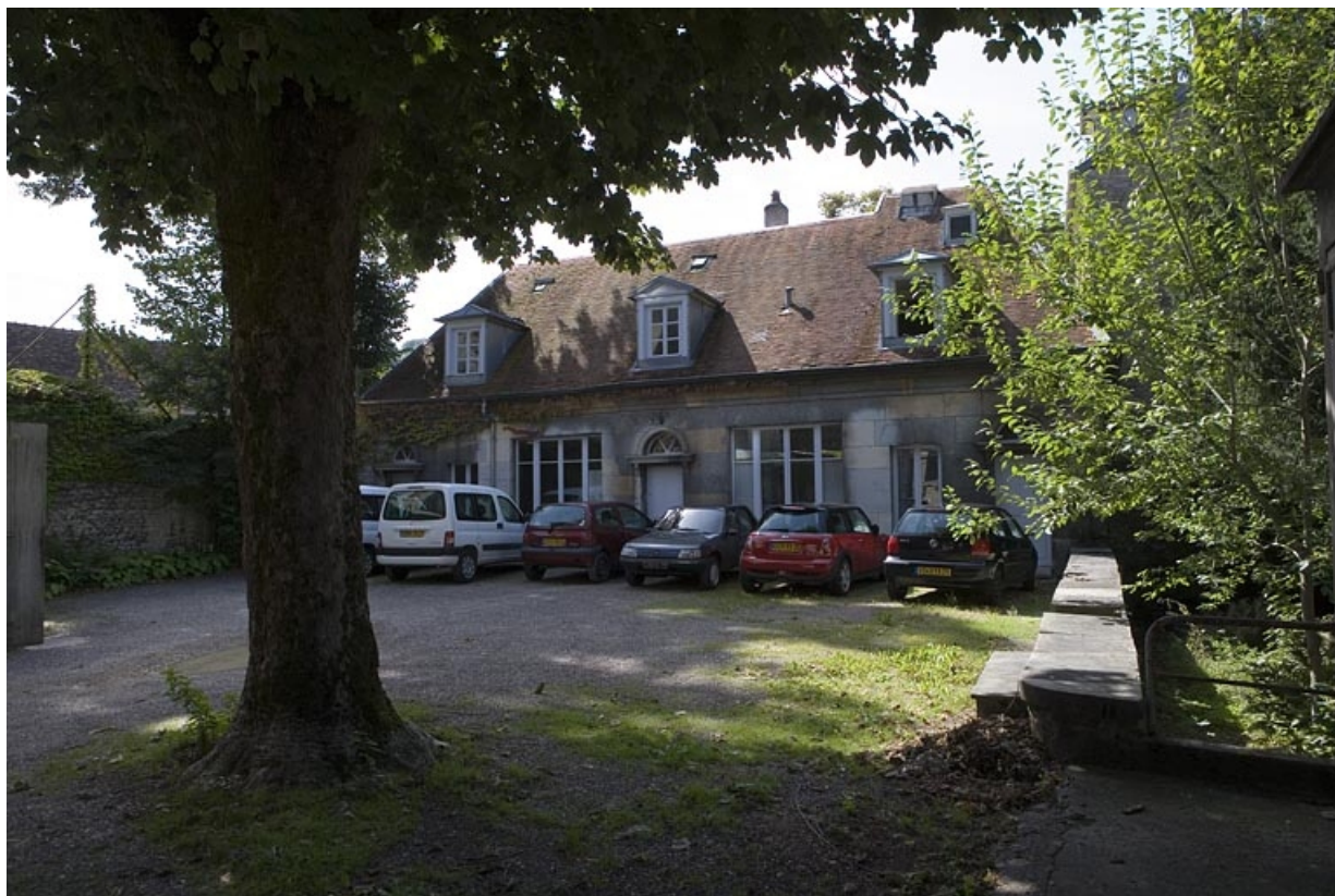
Vue du bâtiment des anciennes remise et écurie situé en fond de parcelle.
