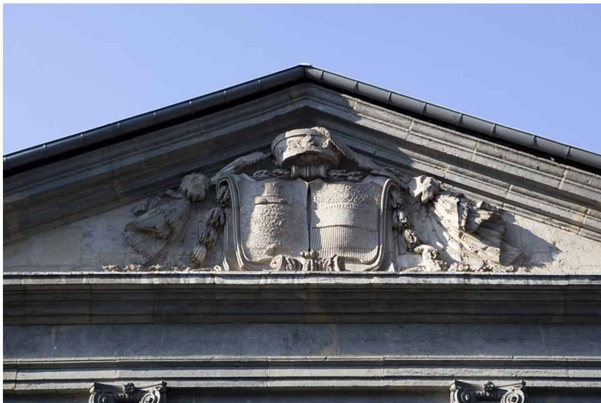
Détail des armoiries bûchées situées dans le fronton couronnant la façade sur rue.
