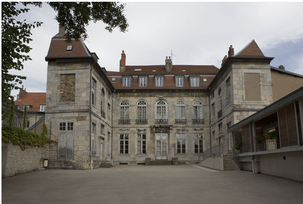
Vue d'ensemble de la façade postérieure du logis principal depuis l'ancien jardin.
