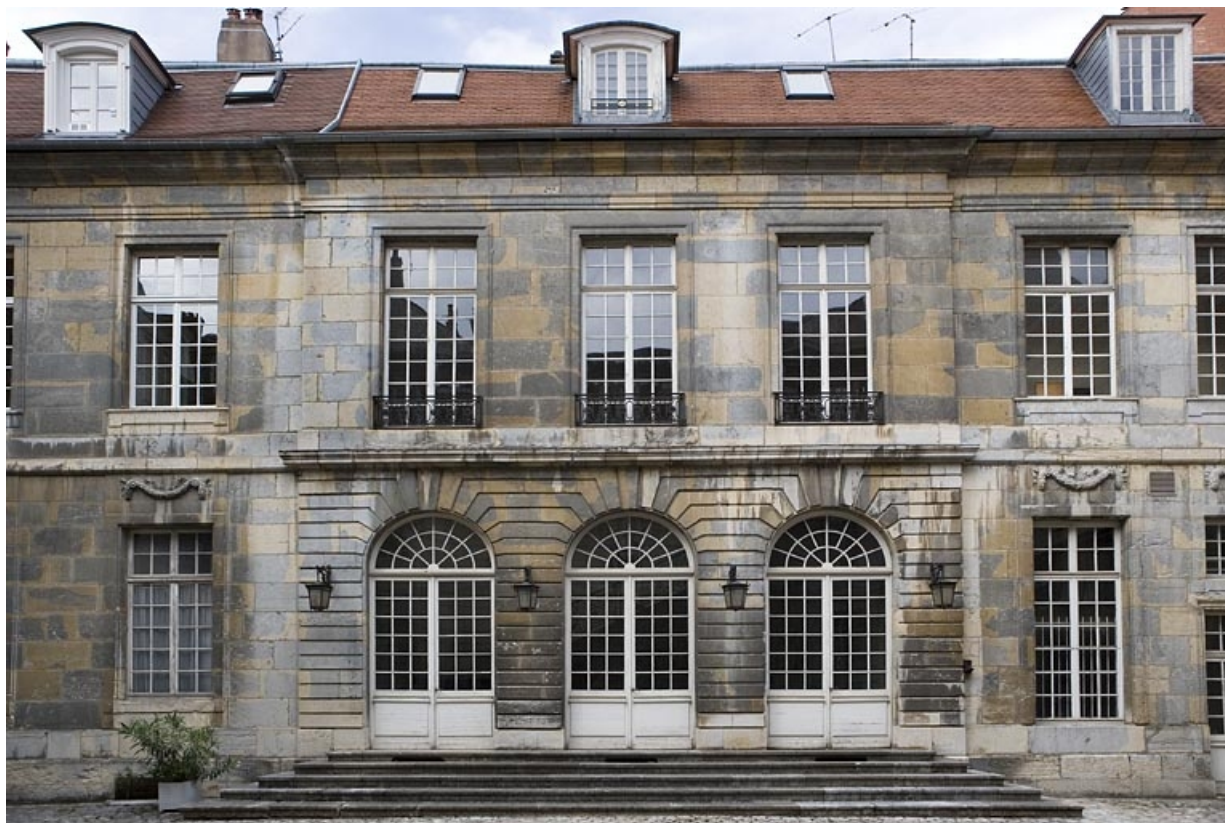
Aile à droite de la cour d'honneur contenant l'escalier.
