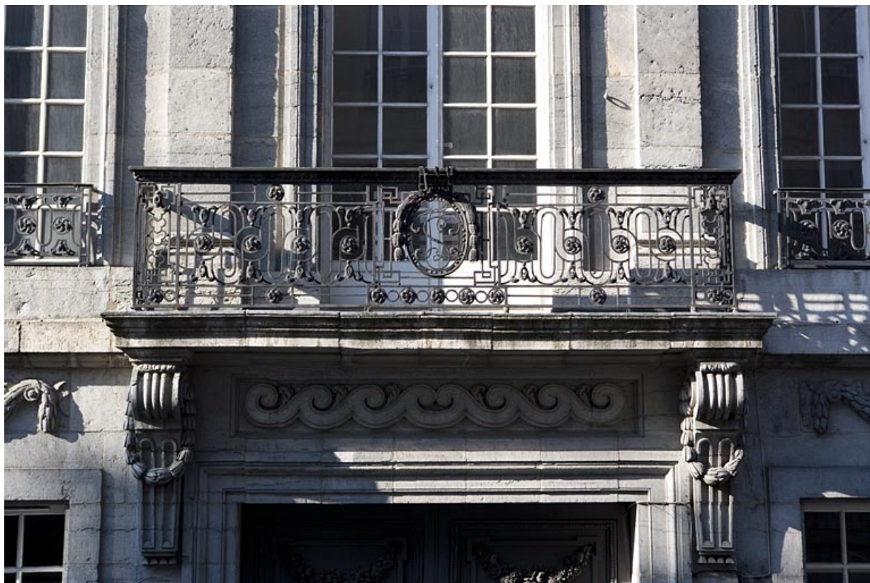
Détail du balcon en ferronnerie, au premier étage sur rue, comportant les armoiries des Terrier de Santans. 25, Besançon Grande Rue 68, lieudit : îlot Terrier de Santans
