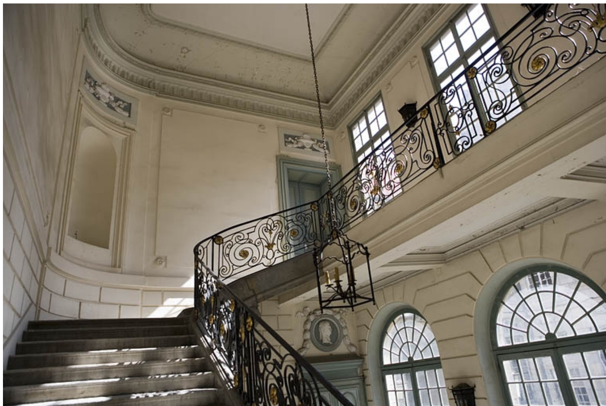
Escalier d'honneur : vue d'ensemble de la cage d'escalier depuis le haut de la dernière volée. 25, Besançon Grande Rue 68, lieudit : îlot Terrier de Santans
