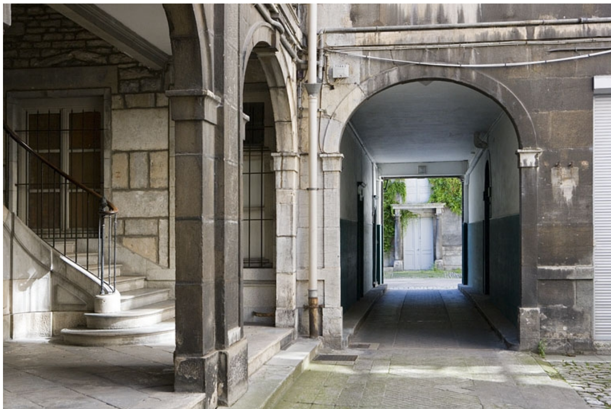
Détail de l'entrée du passage cocher au rez-de-chaussée du logis secondaire. 25, Besançon Grande Rue 74, lieudit : îlot Terrier de Santans
