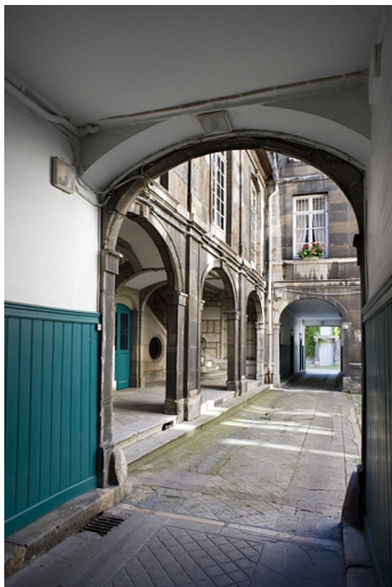
Détail de l'aile droite contenant l'escalier depuis le passage cocher du logis principal. 25, Besançon Grande Rue 74, lieudit : îlot Terrier de Santans
