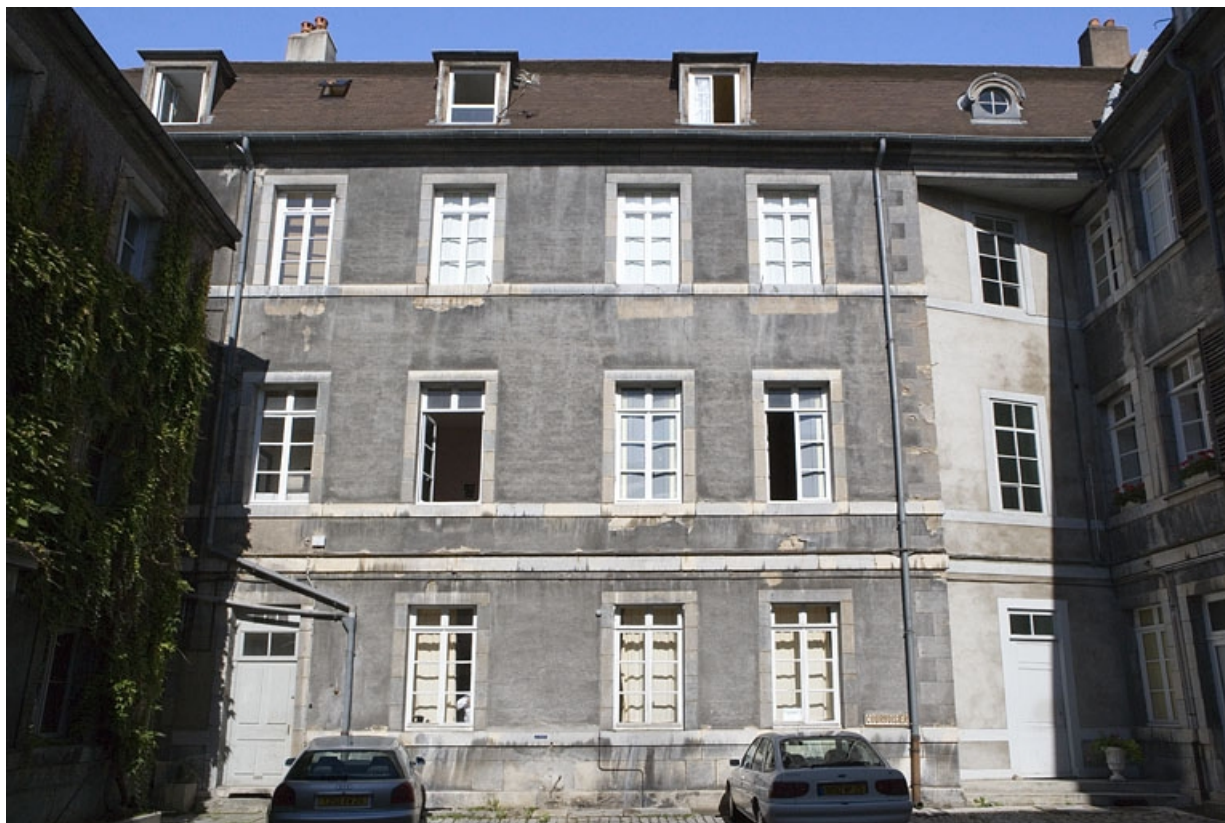
Deuxième cour : vue d'ensemble de l'aile droite, de face. 25, Besançon Grande Rue 74, lieudit : îlot Terrier de Santans
