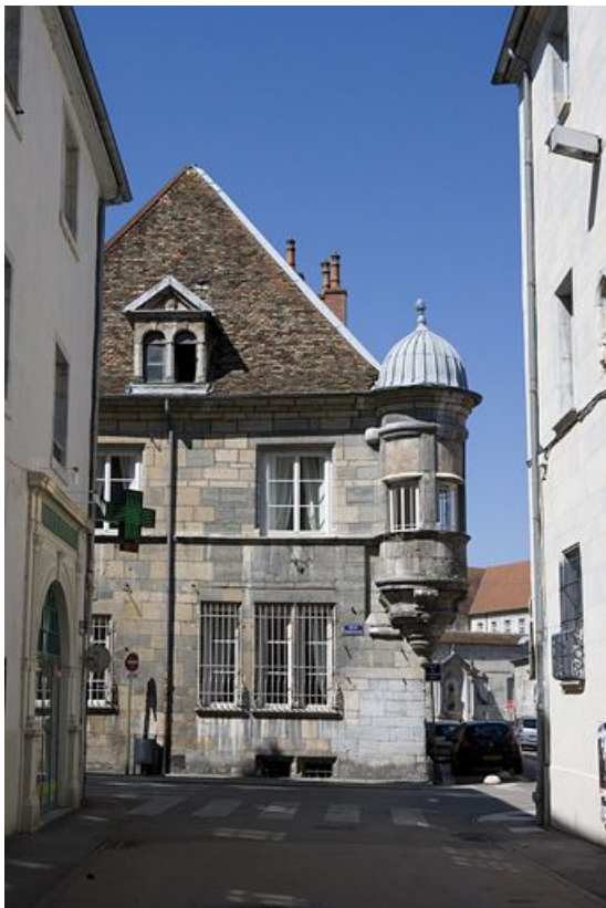
Vue d'une partie du logis principal, de face, depuis la rue d'Anvers.
