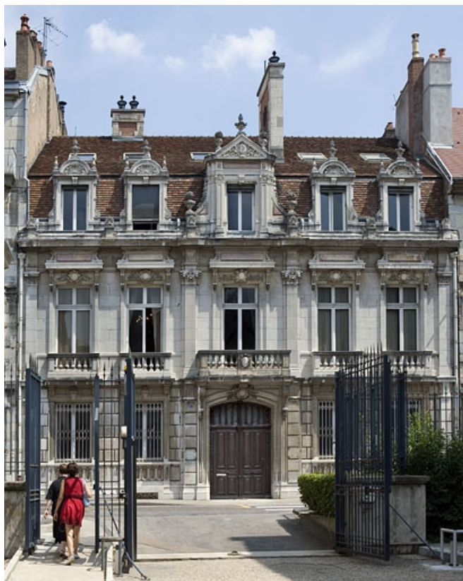
Vue d'ensemble de la façade sur rue, 9 bis rue Charles Nodier, de face.
