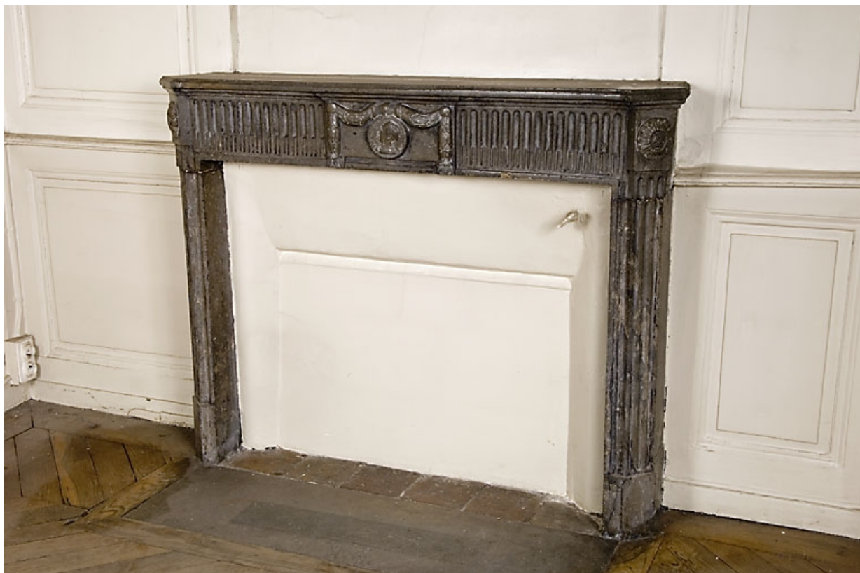
Détail d'une cheminée : pièce au rez-de-chaussée.
