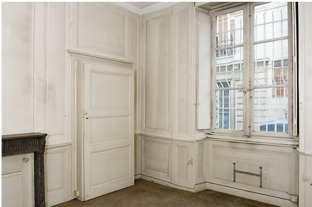
Détail d'une porte dans une pièce du rez-de-chaussée sur rue.
