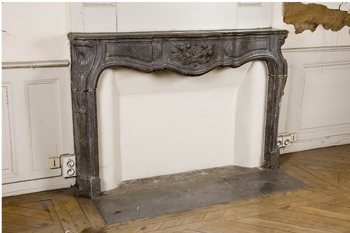
Détail de la cheminée d'une pièce du rez-de-chaussée à gauche de l'escalier principal. 25, Besançon, 9, 9 bis rue Charles Nodier, lieudit : îlot Banque de France
