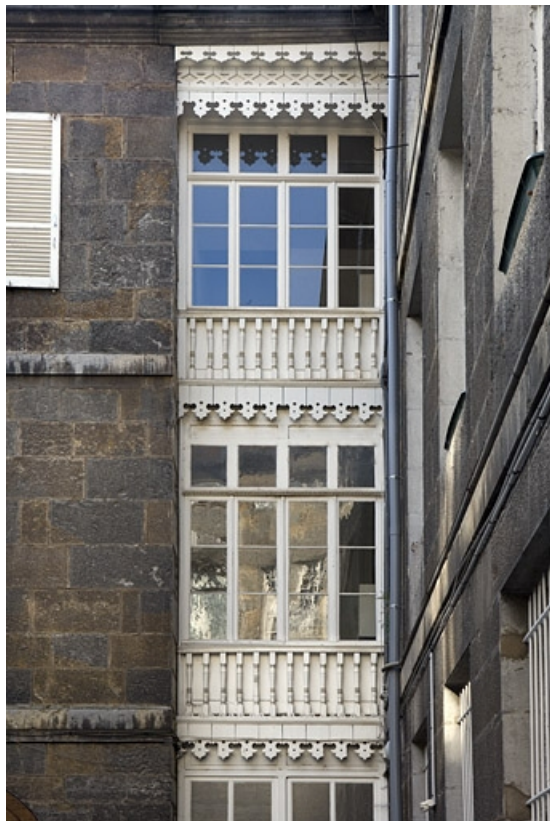
Détail de la façade sur cour de l'escalier secondaire.
