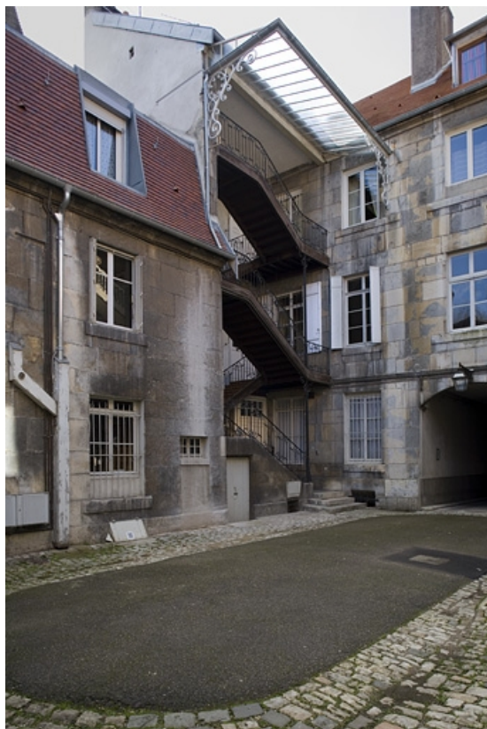
Vue d'ensemble de trois quarts droit depuis le fond de la cour. 25, Besançon, 11 rue Charles Nodier, lieudit : îlot Banque de France
