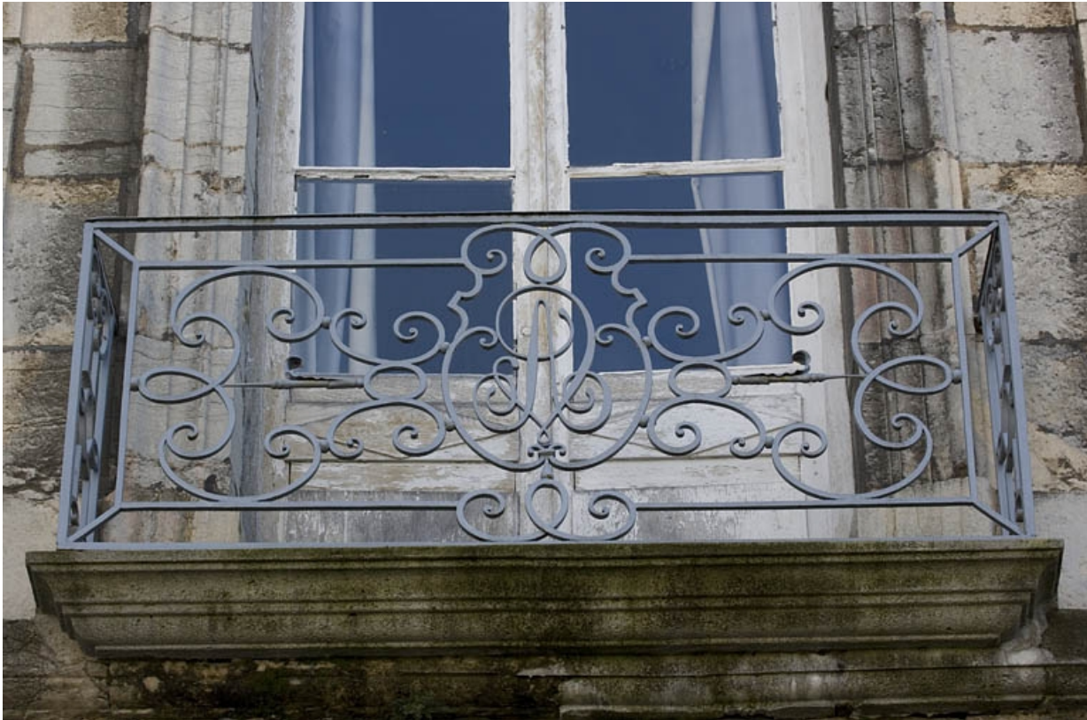
Détail du balcon en fer forgé sur cour.
