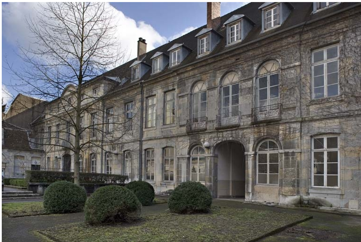
Vue d'ensemble de la façade sur cour de trois quarts droit.
