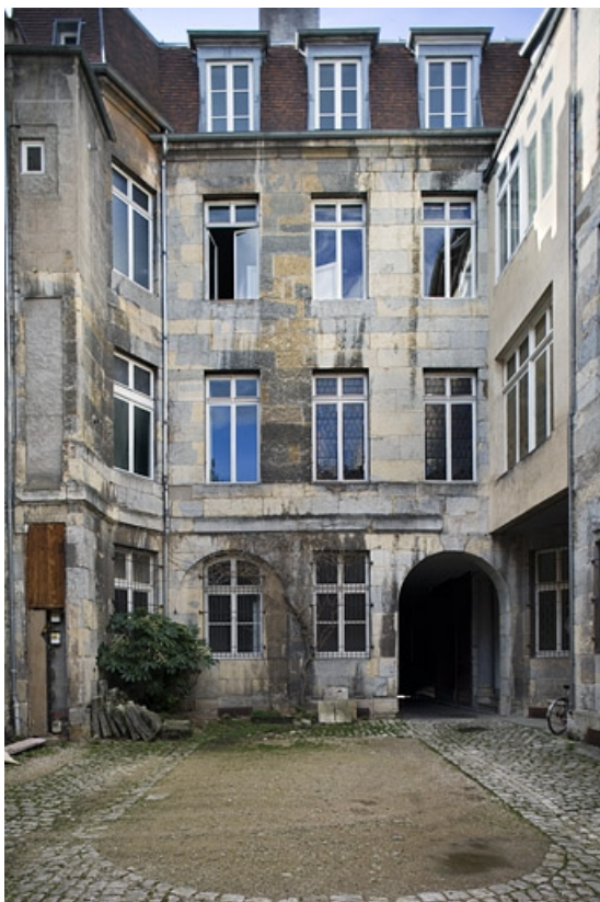
Vue d'ensemble des façades sur cour depuis le fond de la parcelle.
