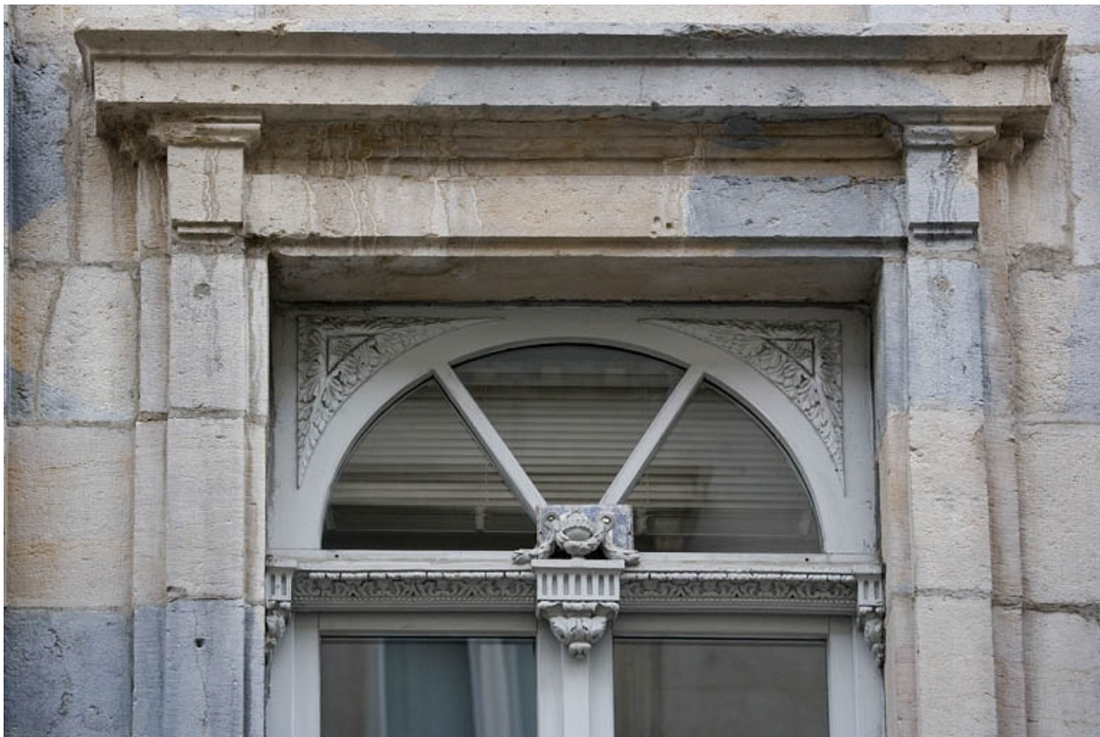
Détail du décor du tympan de la porte-fenêtre donnant sur le balcon.
