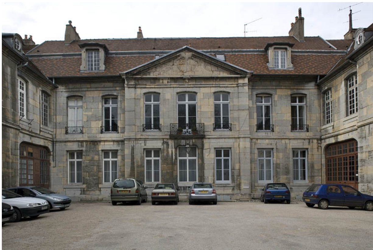
Vue d'ensemble du logis principal depuis l'entrée de la cour.
