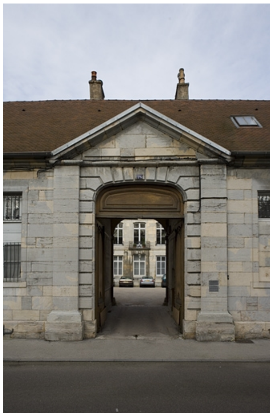
Vue d'ensemble du portail d'entrée dans la cour.
