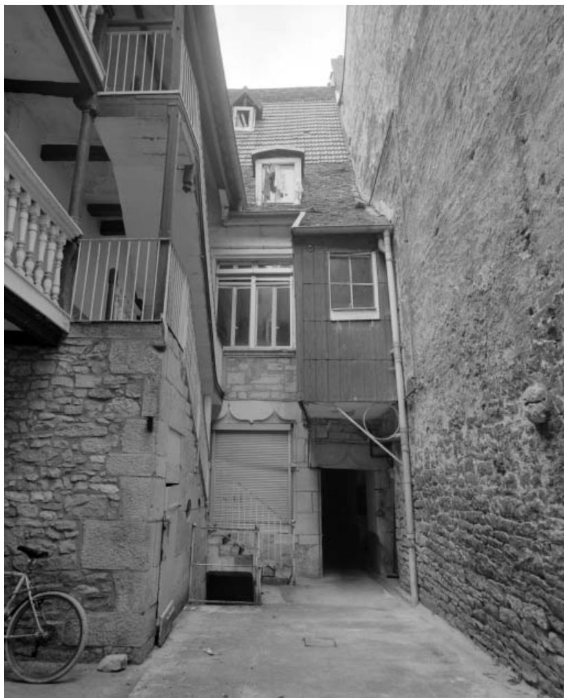
Façade postérieure du logis sur rue et escalier, depuis le fond de la cour. 25, Besançon, 11 rue Claude Pouillet, lieudit : îlot Pasteur
