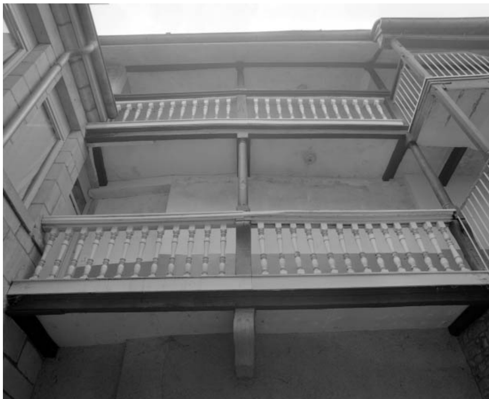
Détail de la coursière prolongeant l'escalier à cage ouverte sur cour.
