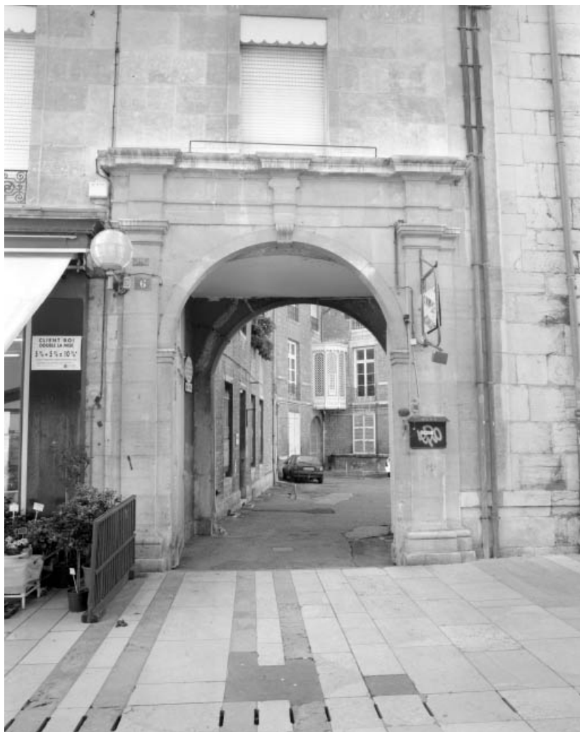
Façade sur rue : détail de l'entrée cochère.
