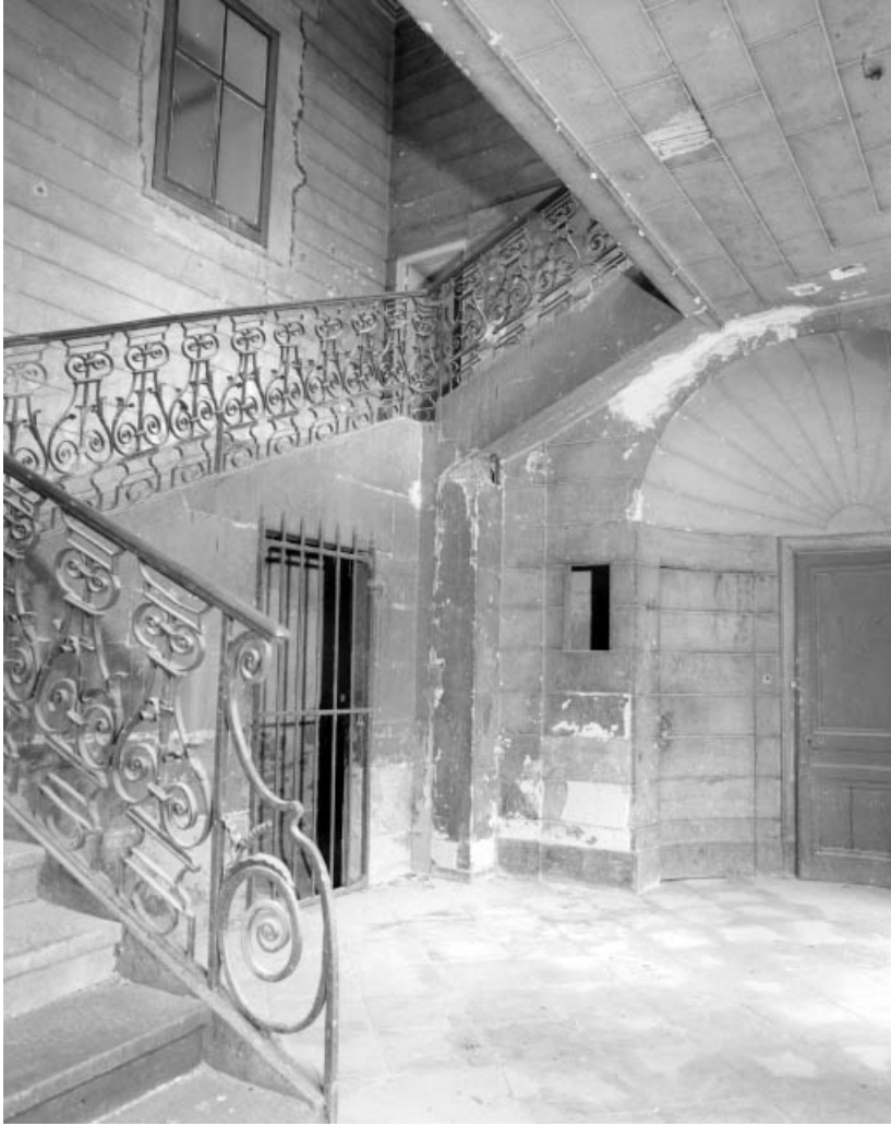
Intérieur : escalier d'honneur, vue d'ensemble en hauteur.
