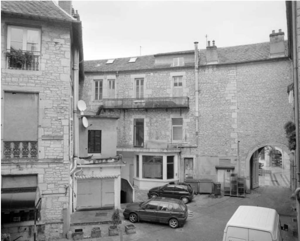
Vue du corps d'entrée depuis le logis sur cour. 25, Besançon, 6 rue Pasteur, lieudit : îlot Pasteur
