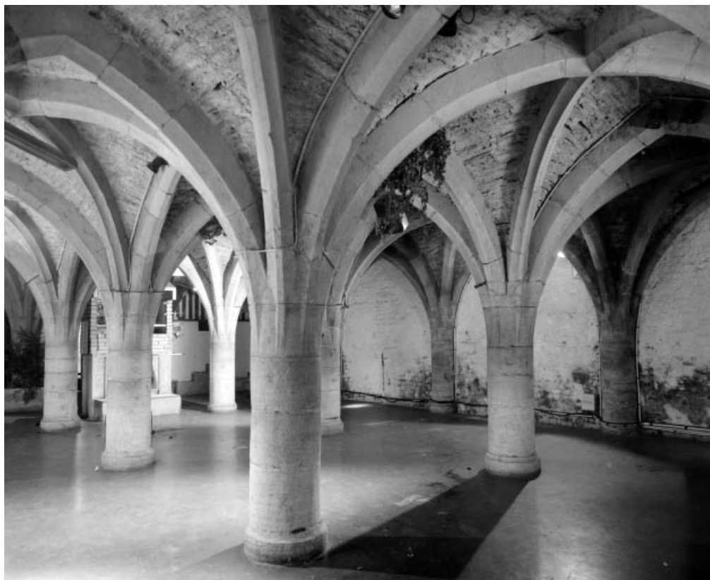
Sous-sol de l'aile droite : vue d'ensemble depuis l'entrée, de trois-quart droit. 25, Besançon, 6 rue Pasteur, lieu-dit : îlot Pasteur
