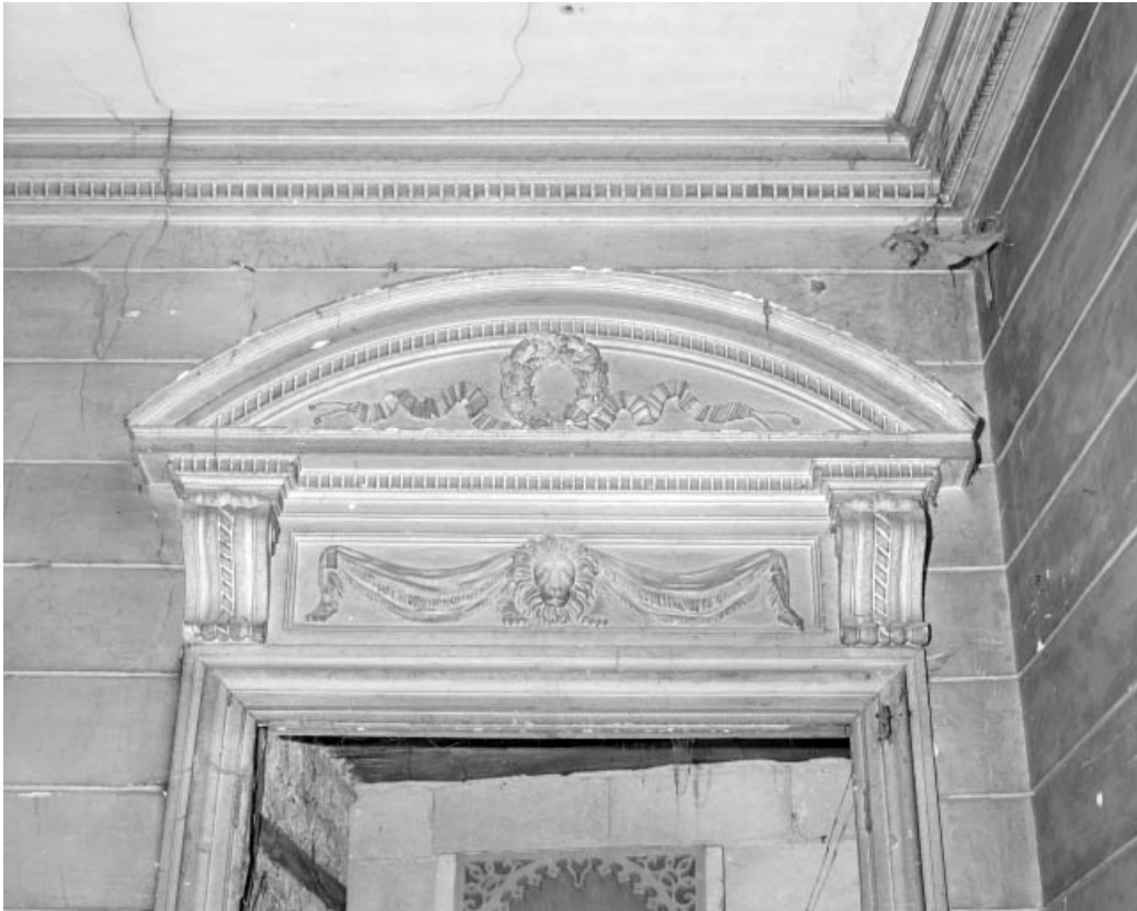
Intérieur : escalier d'honneur, porte gauche sur le palier, détail du fronton.
