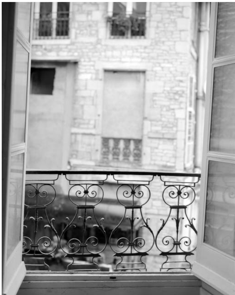
Façade antérieure sur cour : détail de la ferronnerie d'un garde-corps.
