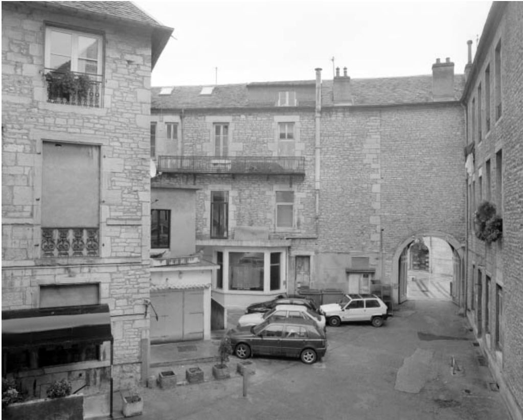
Vue de la cour antérieure depuis le logis sur cour, de trois-quart gauche.
