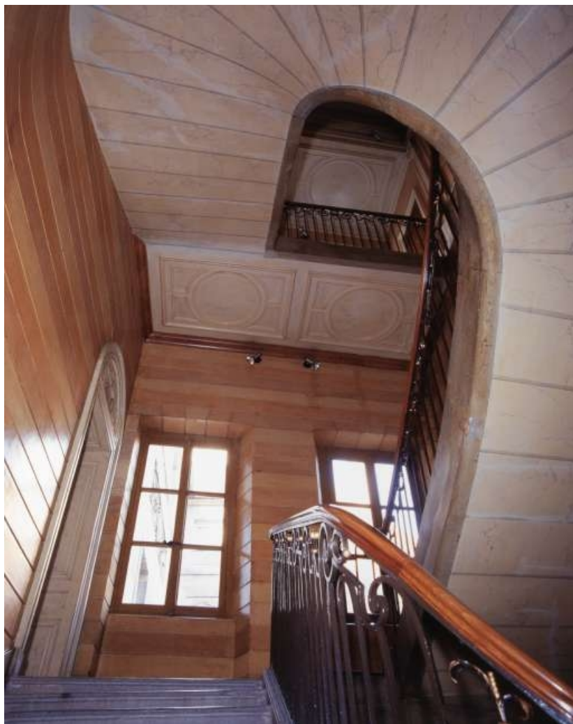
Vue d'ensemble de la cage de l'escalier d'honneur depuis le premier repos. 25, Besançon, 3 rue du Lycée, lieudit : îlot Pasteur
