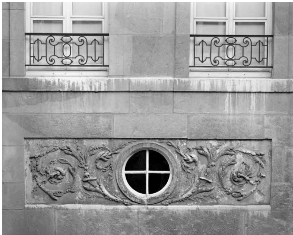
Façade sur cour : détail des décors de l'avant-corps droit.
