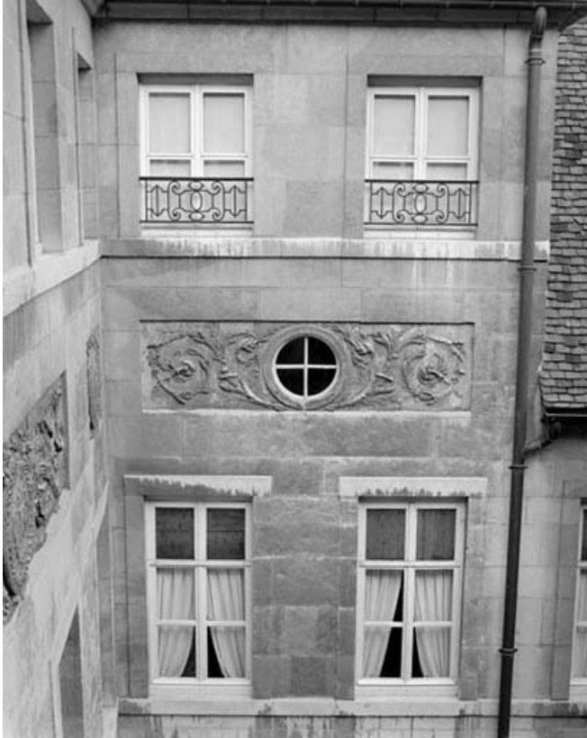
Façade sur cour : détail des décors de l'avant-corps droit.
