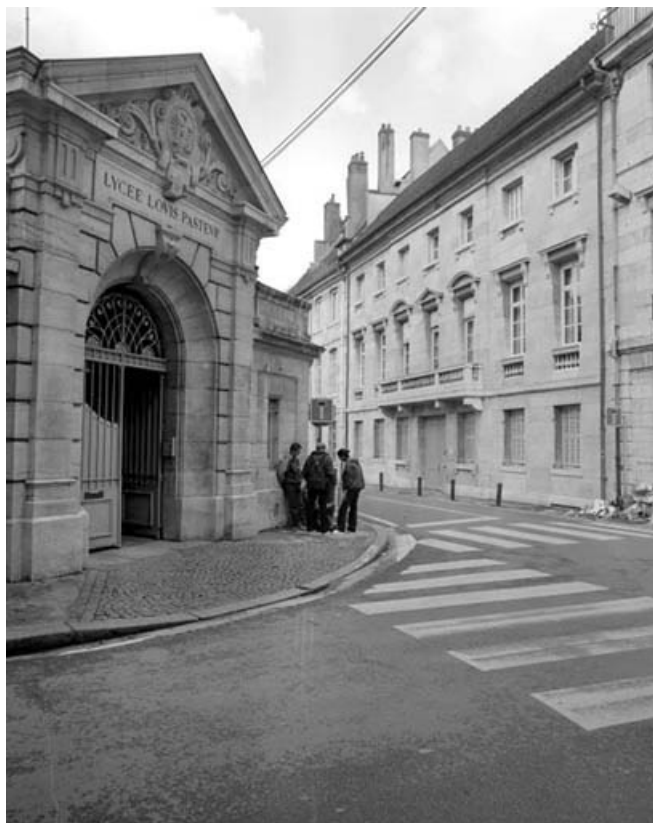
Vue d'ensemble de la façade sur rue, de trois quarts droit.
