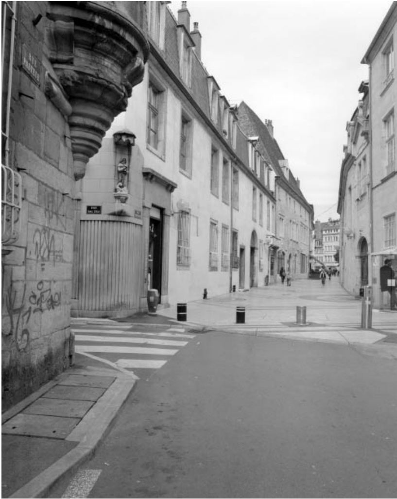
Vue d'ensemble de la façade sur rue, de trois quarts gauche.
