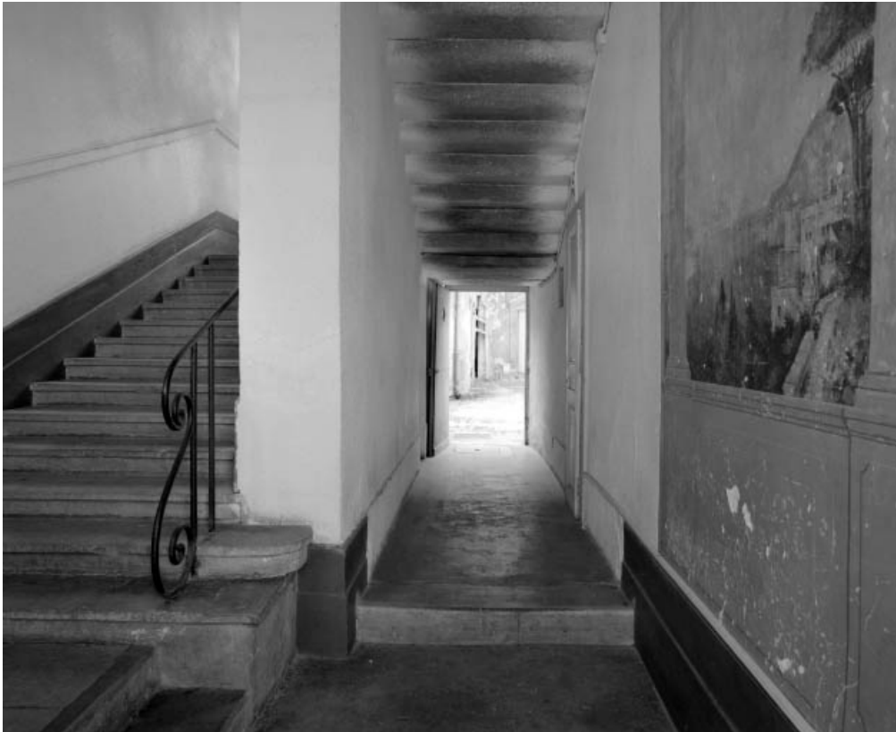
Vue d'ensemble de l'escalier et du couloir d'accès depuis la porte piétonne.
