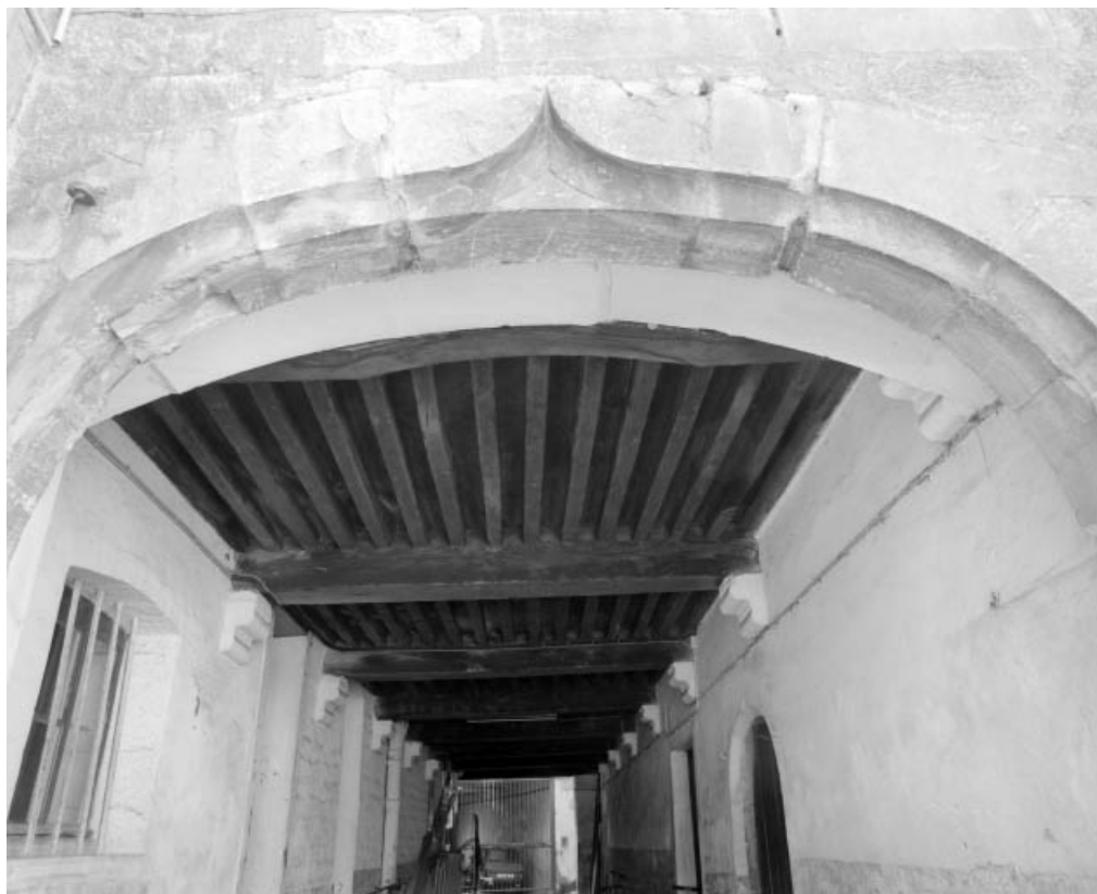
Passage dans la deuxième cour : détail de l'entrée et du plafond à la française.
