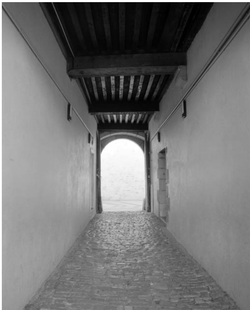
Vue d'ensemble de l'allée cochère du logis principal depuis la première cour : vue rapprochée. 25, Besançon, 8 rue Pasteur, lieudit : îlot Pasteur
