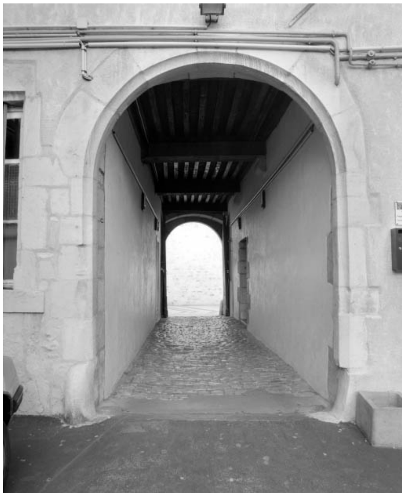
Vue d'ensemble de l'allée cochère du logis principal depuis la première cour. 25, Besançon, 8 rue Pasteur, lieudit : îlot Pasteur
