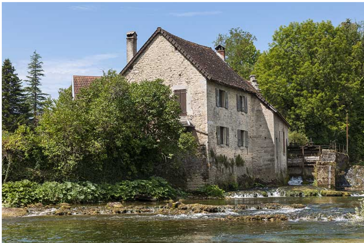
Logement et atelier du martinet depuis la rive gauche, à l'est.
