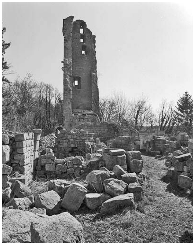
Élévation de la tour Saint-Denis depuis l'ouest.
