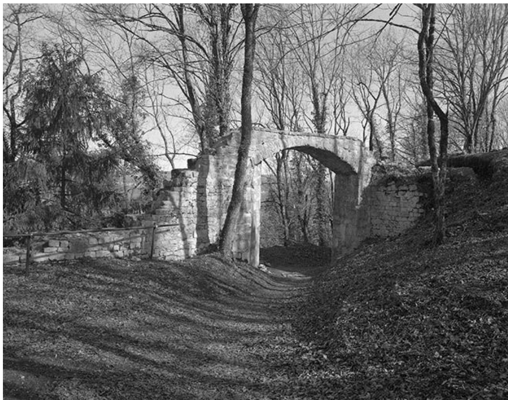
Porte nord conduisant dans la vallée de la Loue. 25, Chassagne-Saint-Denis, lieudit : sur Saint-Denis
