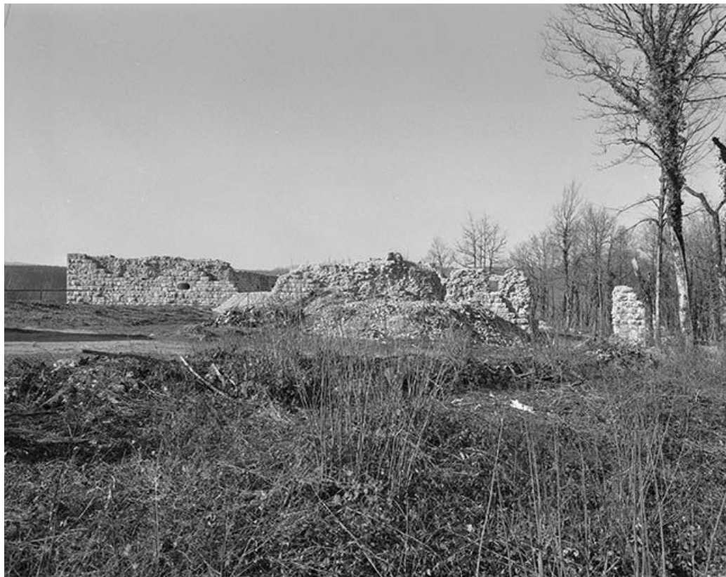
Vue générale du mur d'enceinte depuis l'est.
