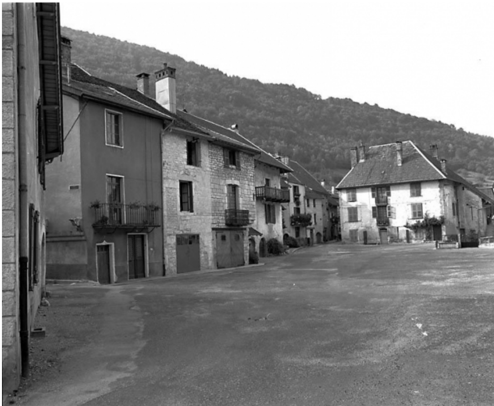
Façade antérieure vue de trois quarts gauche. 25, Vuillafans
