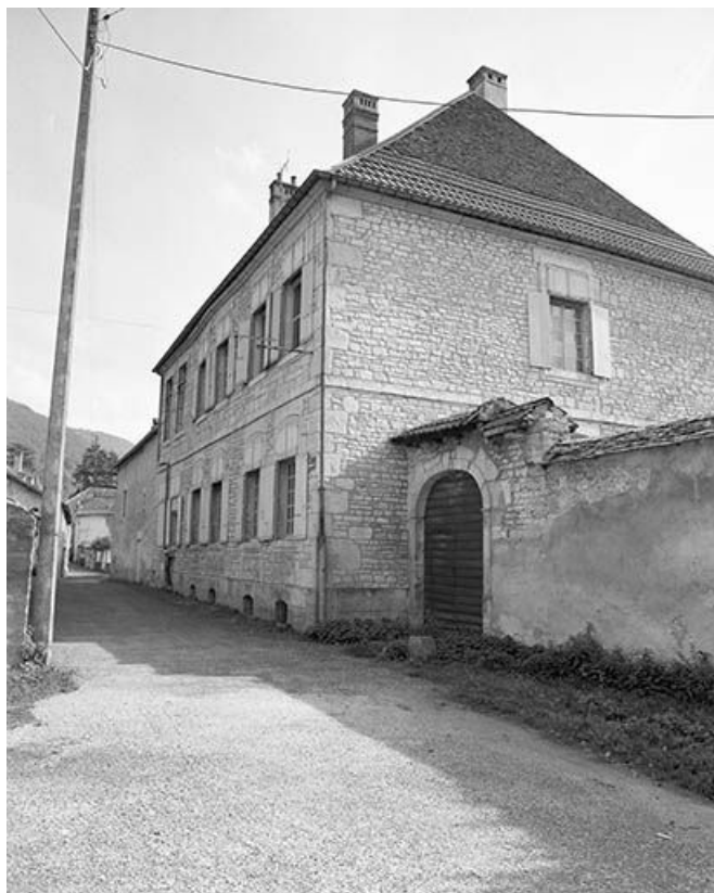
Façade sur la rue Saint-Antoine. 25, Vuillafans
