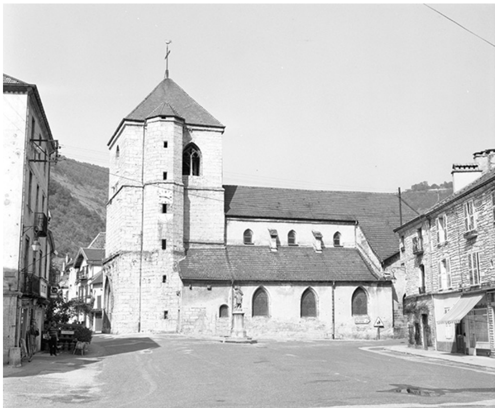
Vue d'ensemble du côté droit (sans le chœur). 25, Vuillafans
