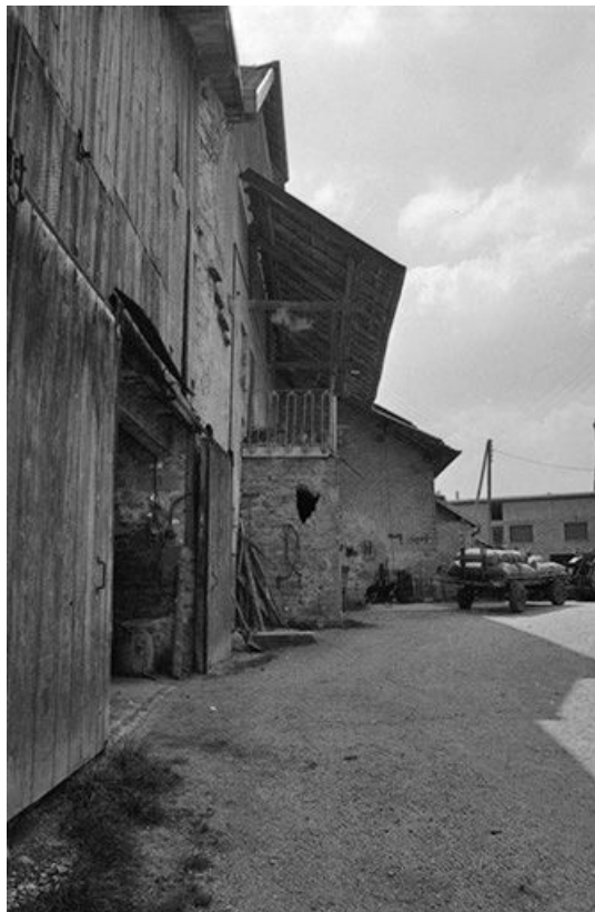
maison de vigneron : façades postérieure et latérale gauche. 25, Tarcenay
