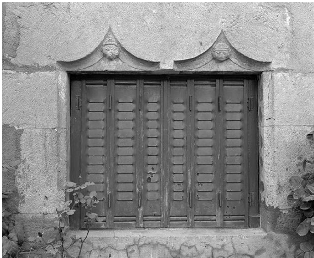
Maison située à Maisières-Notre-Dame, cadastrée 1971 AB 23 : linteau de baie orné de têtes humaines. 25, Scey-Maisières
