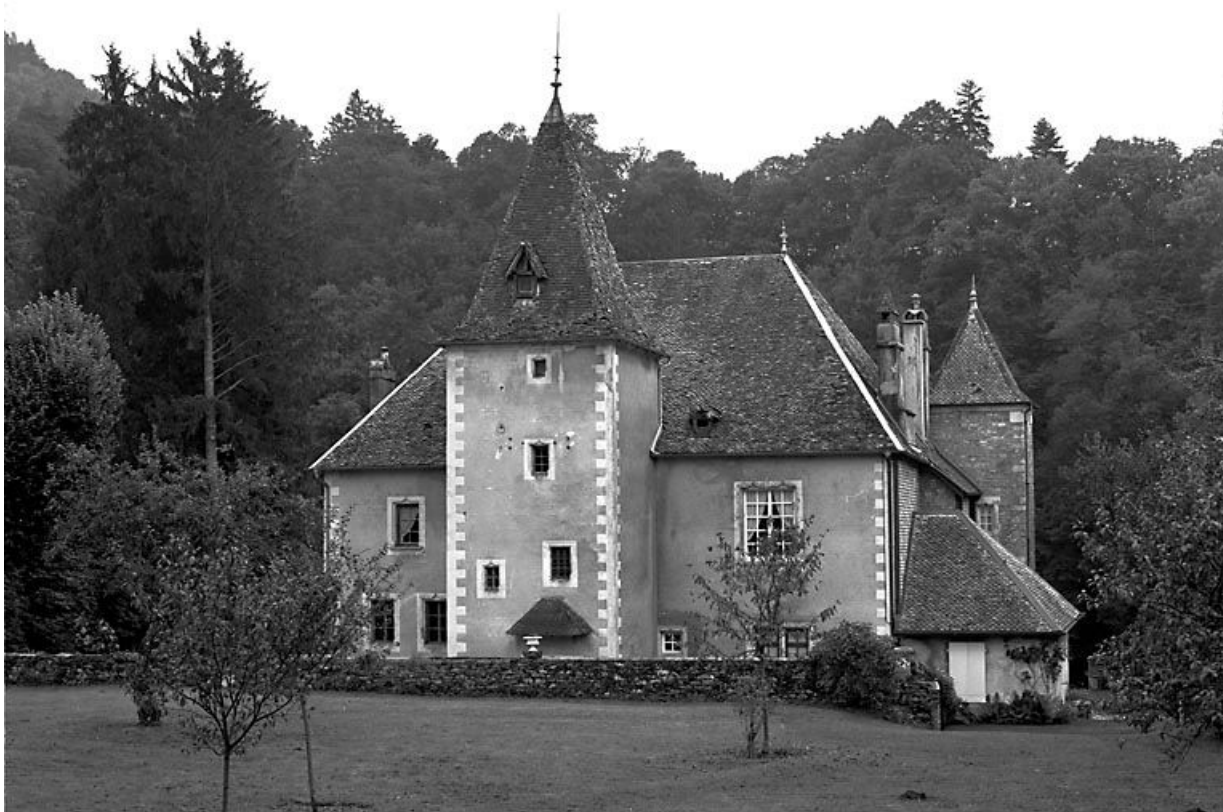
Façade antérieure. 25, Scey-Maisières
