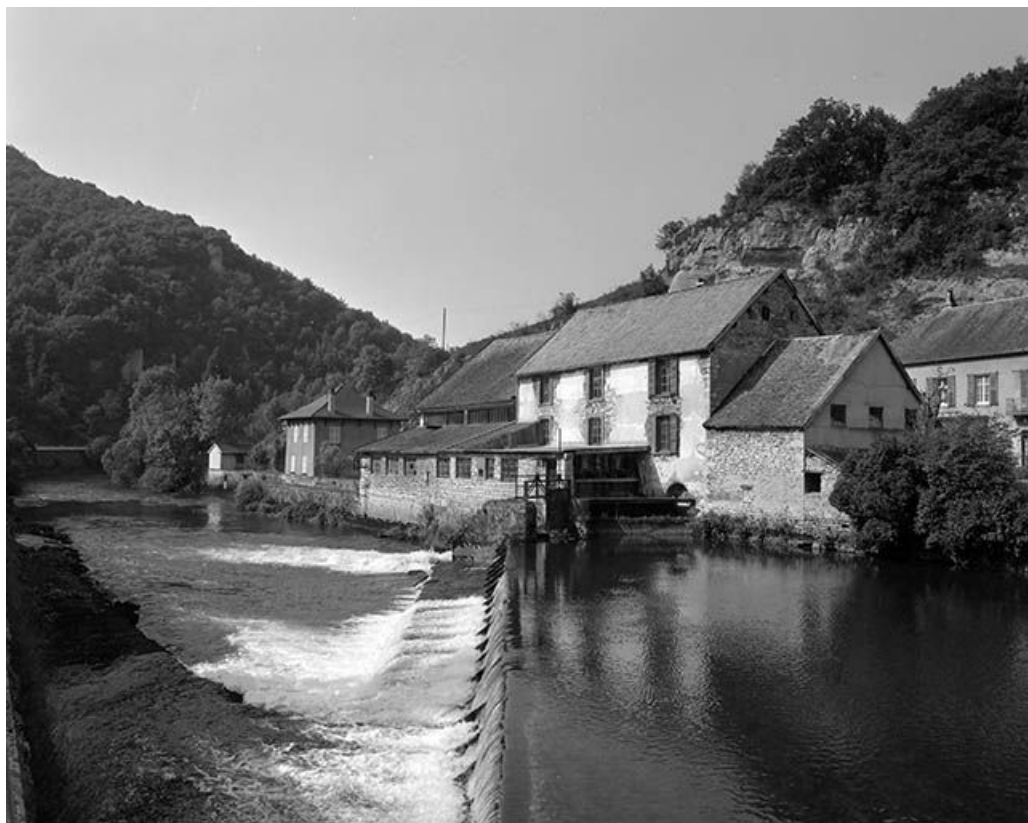
Vue générale, depuis la rive gauche de la Loue, de la minoterie Hanriot, cadastré 1971 AB 15. 25, Lods
