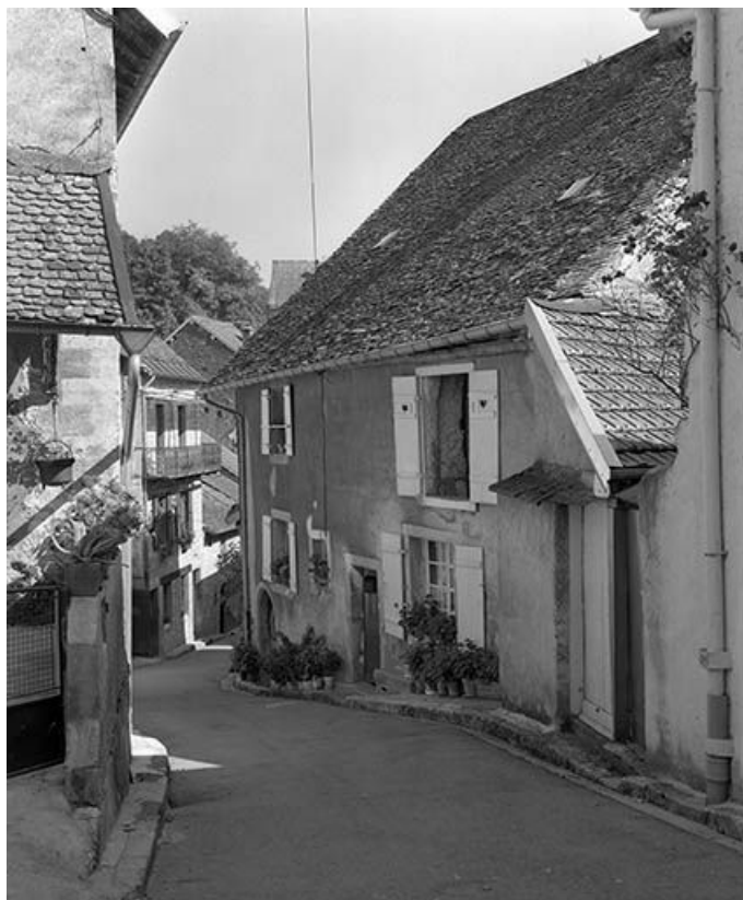
La descente de la rue de Reine.
