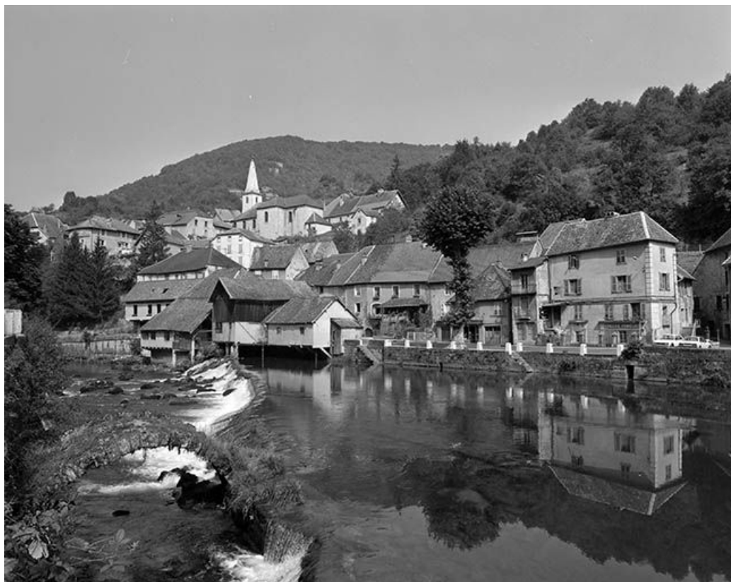
Vue générale depuis le sud-est.
