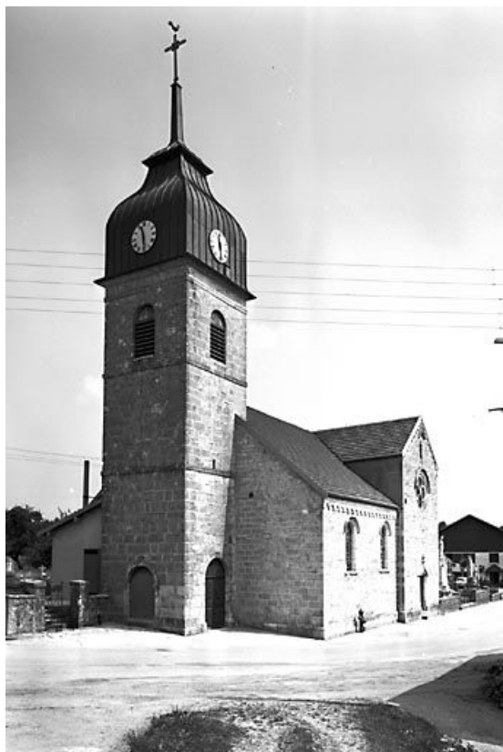
Façade antérieure et face latérale droite. 25, Guyans-Durnes
