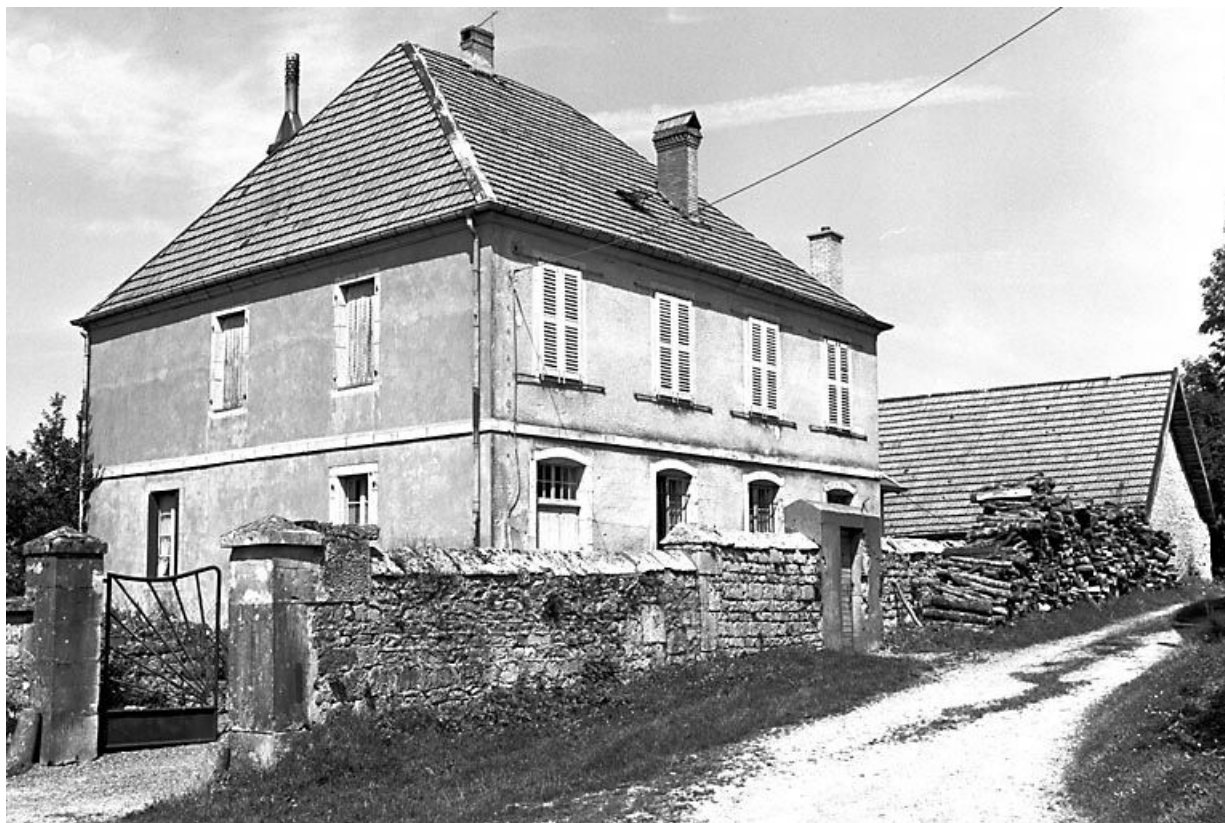
Façade antérieure et face latérale gauche. 25, Foucherans
