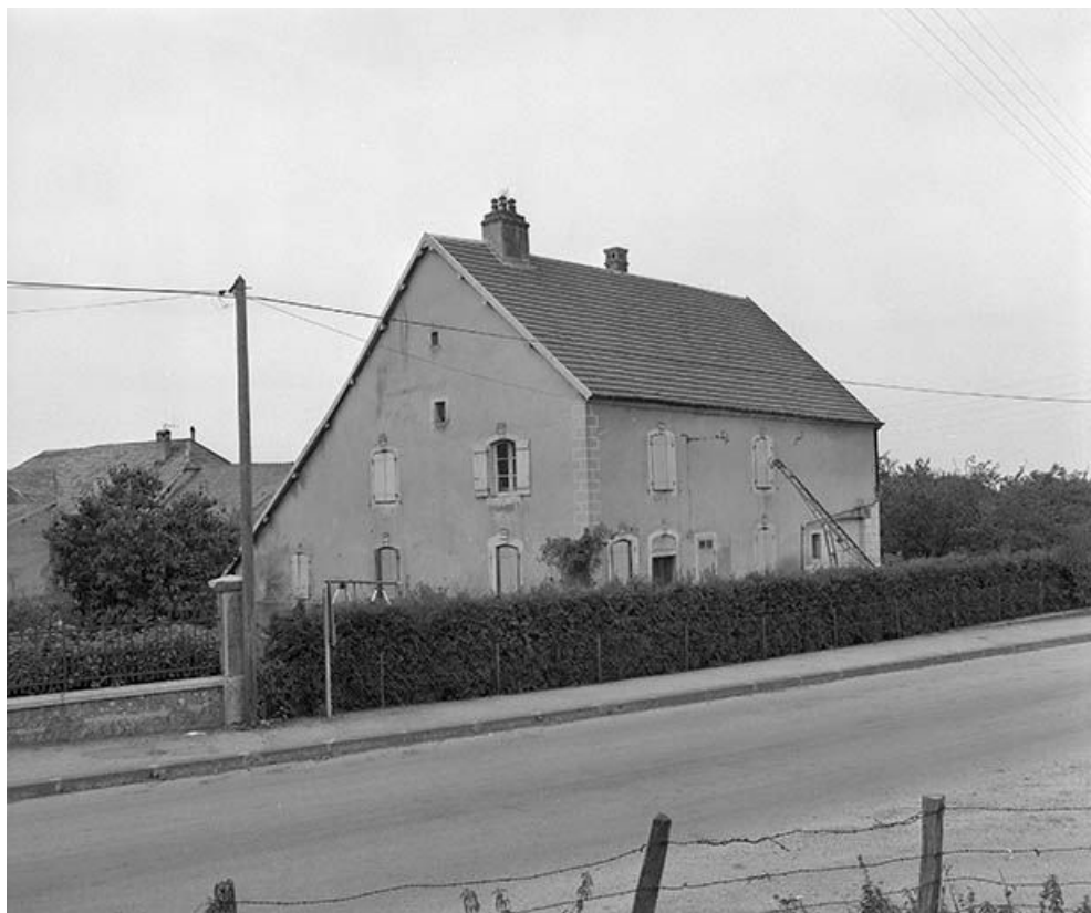
Façade antérieure et face latérale gauche. 25, Chantrains
