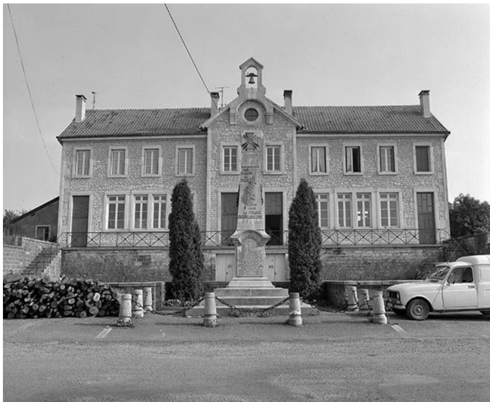
Façade antérieure. 25, Trépot
