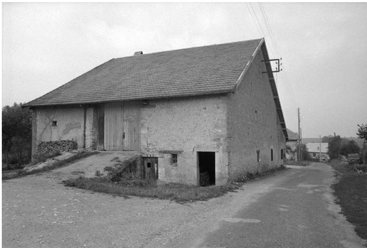
Ferme située rue de l'Abreuvoir, cadastrée 1972 AB 189 : vue depuis la rue. 25, Trépot
