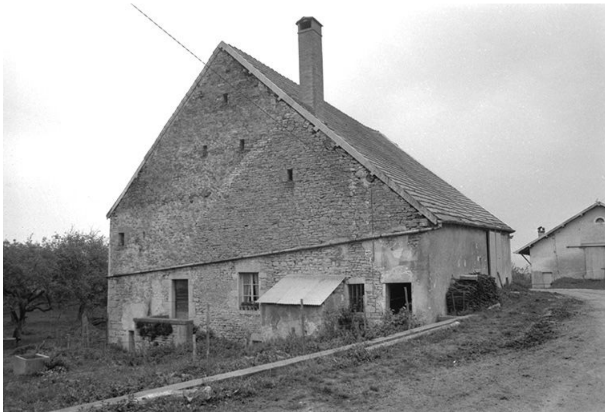
Façade antérieure et face latérale droite. 25, Malbrans
