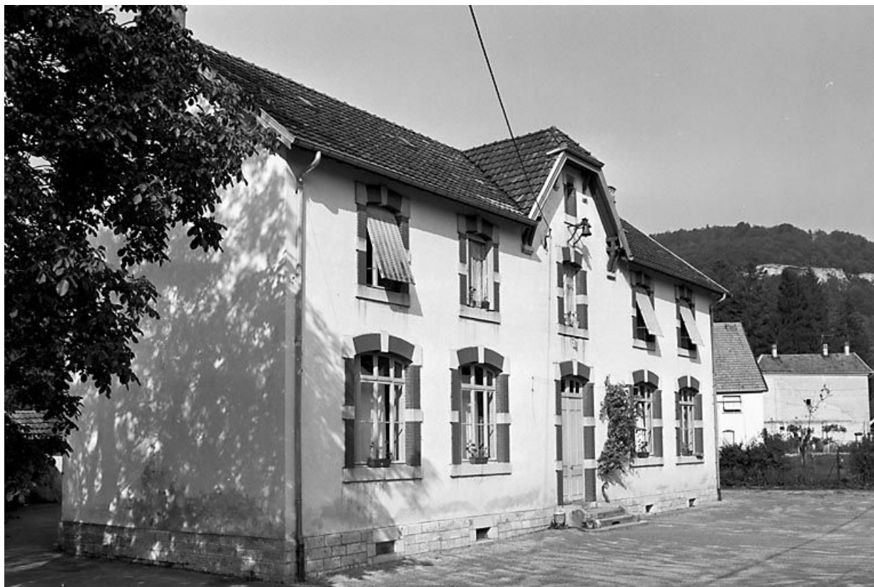
Façade antérieure de trois quarts gauche. 25, Montgesoye
