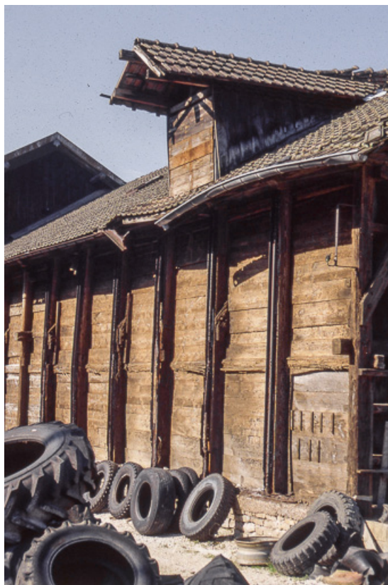
Détail de façade d'un magasin industriel.
