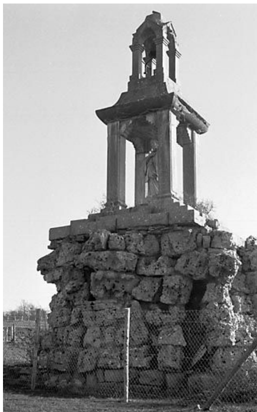
Vue générale. 25, Échevannes
