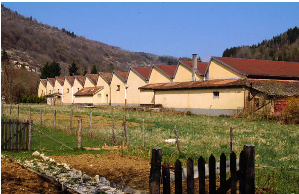
Mur-pignons ouest et sheds des ateliers de la nouvelle usine de bonneterie. 25, Ornans, 1 route de Saules
