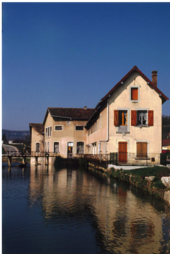
Ancien moulin depuis l'est.
