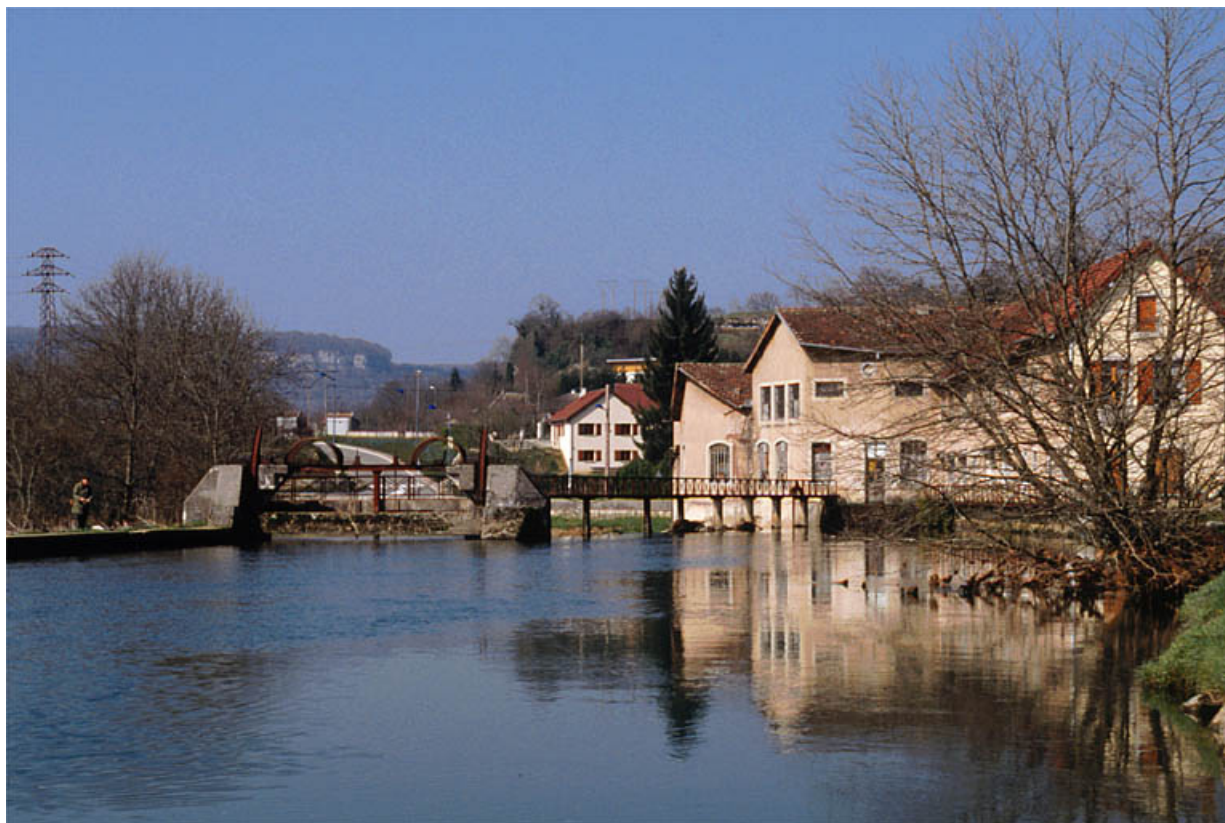
Vue d'ensemble de l'ancien moulin depuis l'est.
