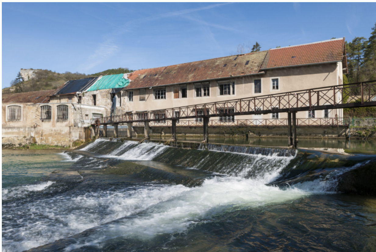
Façades sud des bâtiments du moulin.
