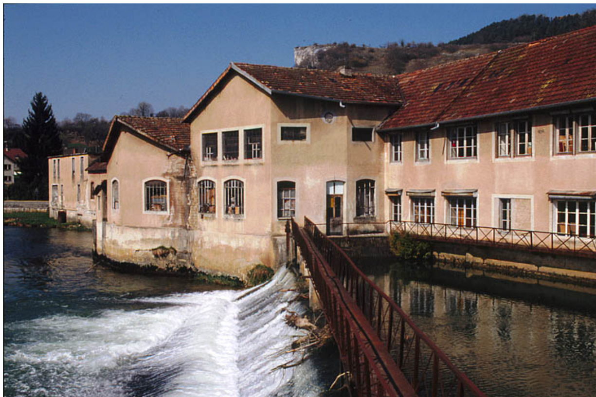
Bâtiment d'eau et atelier de fabrication du moulin depuis la passerelle du barrage.
