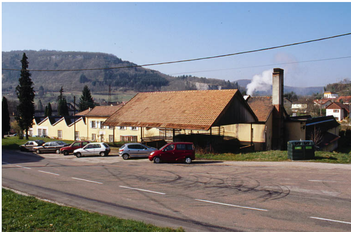
Vue depuis le nord-est.
