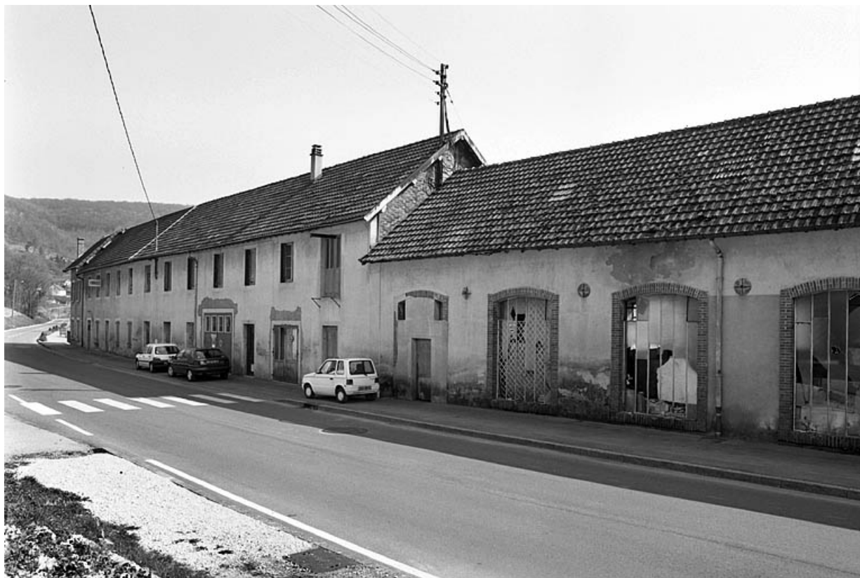
Façade sur rue de l'ancien moulin et de l'atelier de bonneterie primitif. 25, Ornans, 1 route de Saules
