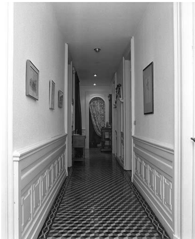
Vue générale du couloir du 4ème étage depuis le salon d'angle.
