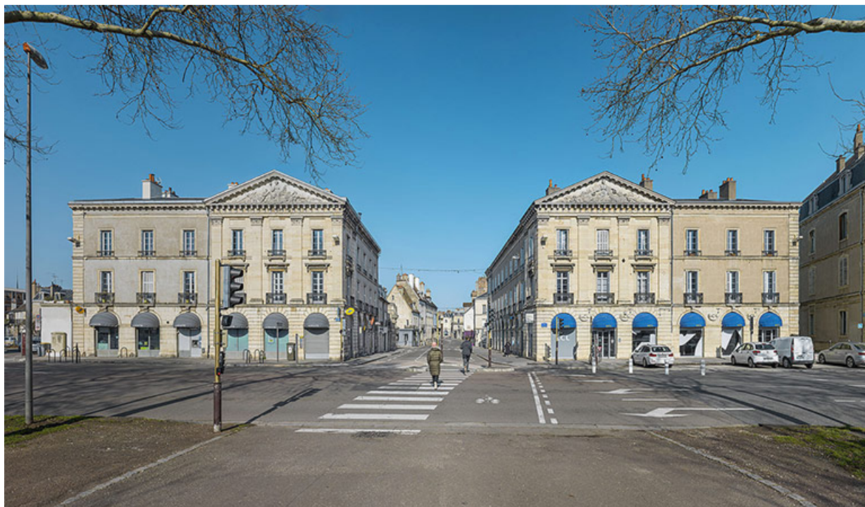
La rue Chabot-Charny, vue depuis la place Wilson : ancien emplacement du boulevard et de la porte Saint-Pierre. 21, Dijon
