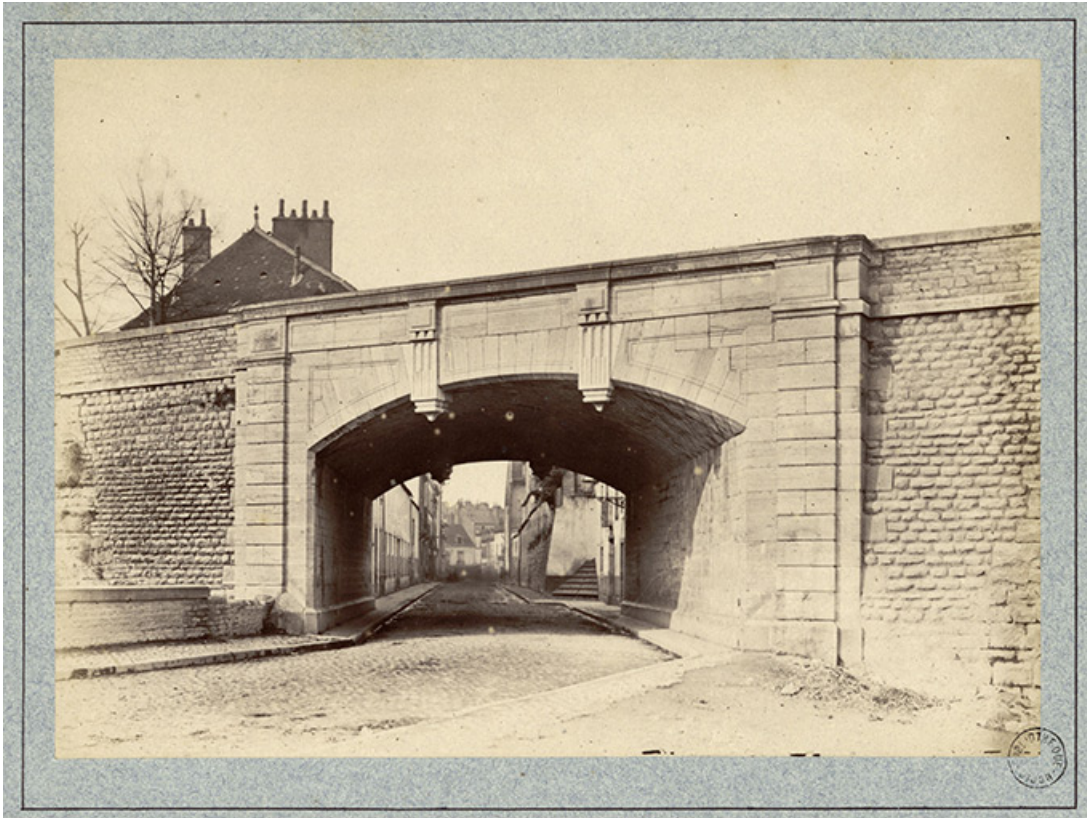
Porte de la Manutention, ouverte en 1860 et démolie avec le rempart en 1883. 21, Dijon
