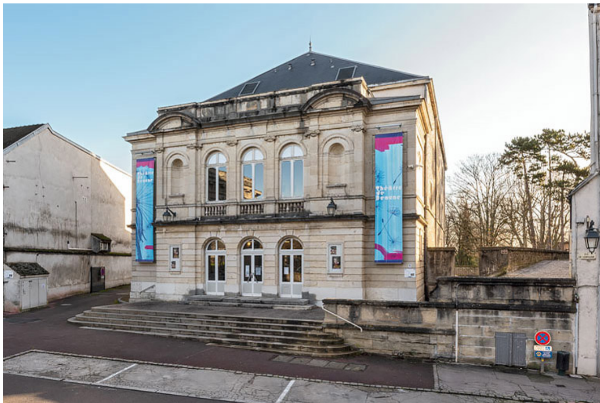
Vue d'ensemble sur la rue de Lorraine.
