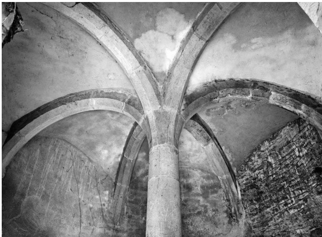
Tour Blondeau, casemate inférieure, détail : voûtement
