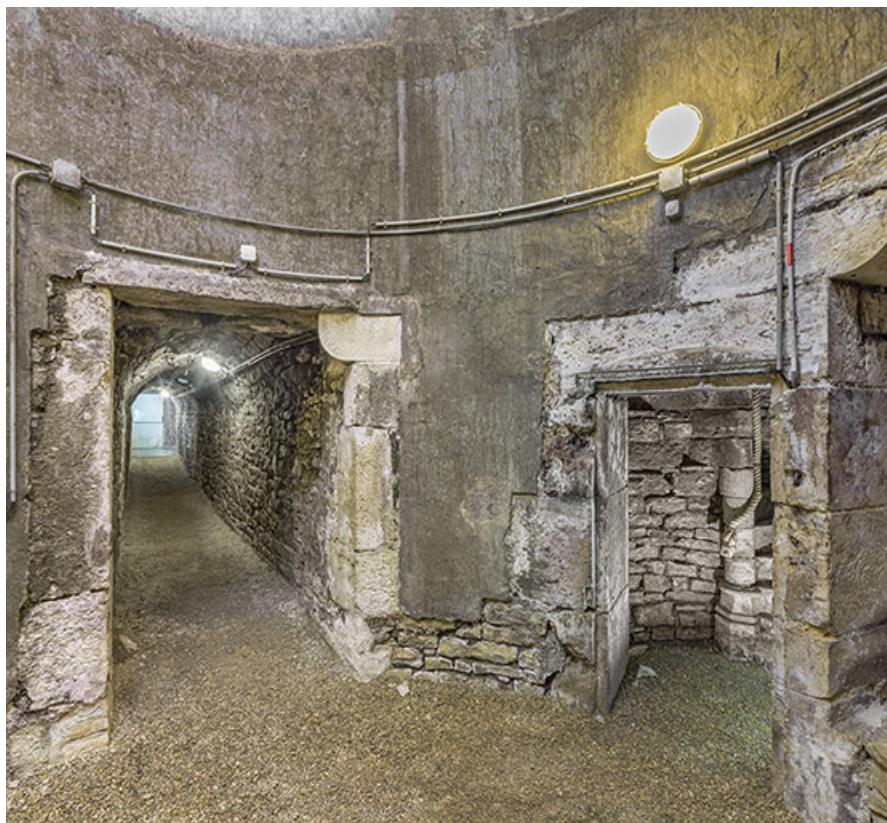
Niveau inférieur : à gauche la galerie, à droite la porte vers l'escalier de la tour. 21, Beaune boulevard Saint-Jacques
