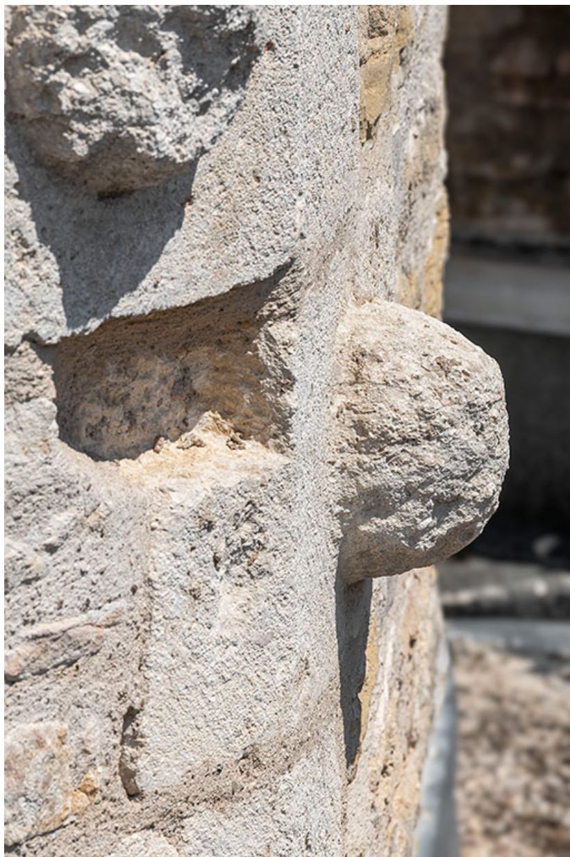
Détail du bossage (plateforme).
