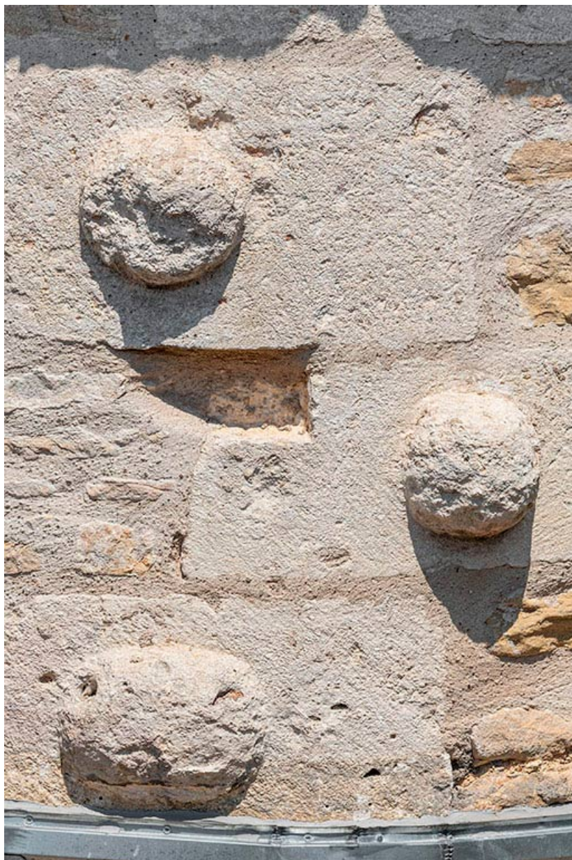
Bossage au niveau de la plateforme.
