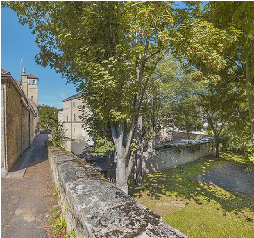
Rempart de la Comédie en direction de l'ancien bastion.
