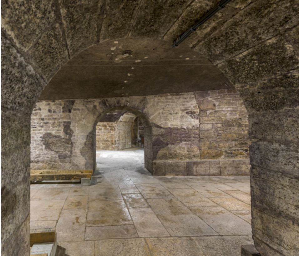
Caves, rez-de-chaussée : passages pour accéder aux différents vaisseaux. 21, Beaune boulevard Maréchal Foch
