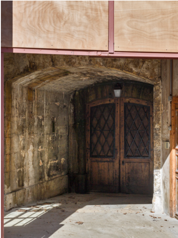
Entrée de la tour au rez-de-chaussée.
