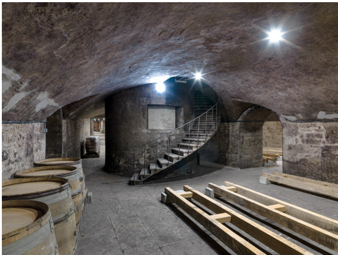
Caves, rez-de-chaussée : vaisseau central et le monte-charge.
