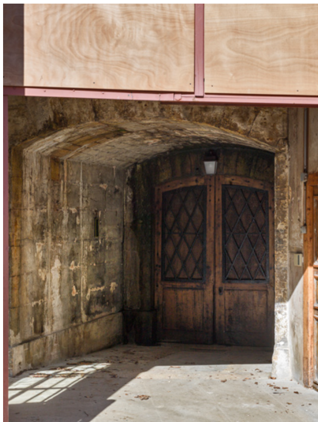
Entrée de la tour au rez-de-chaussée.
