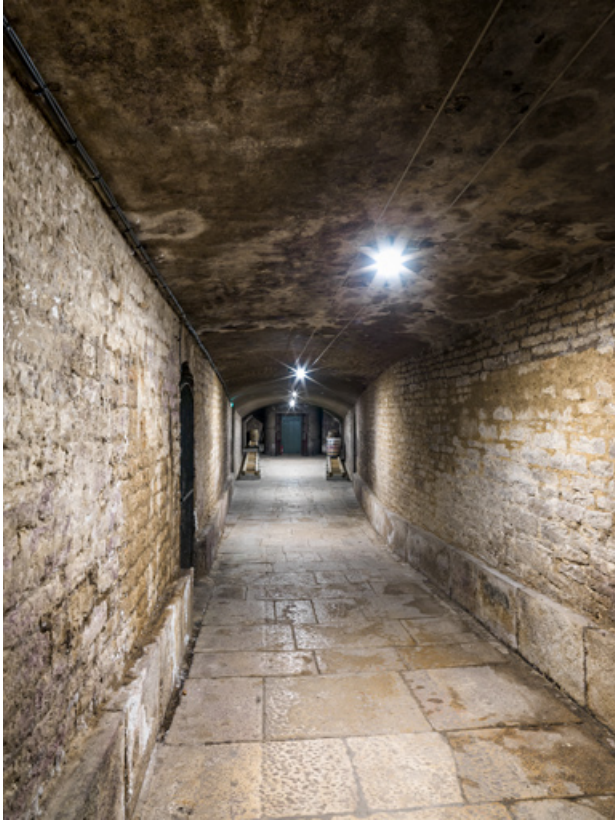
Galerie menant vers les caves, rez-de-chaussée.
