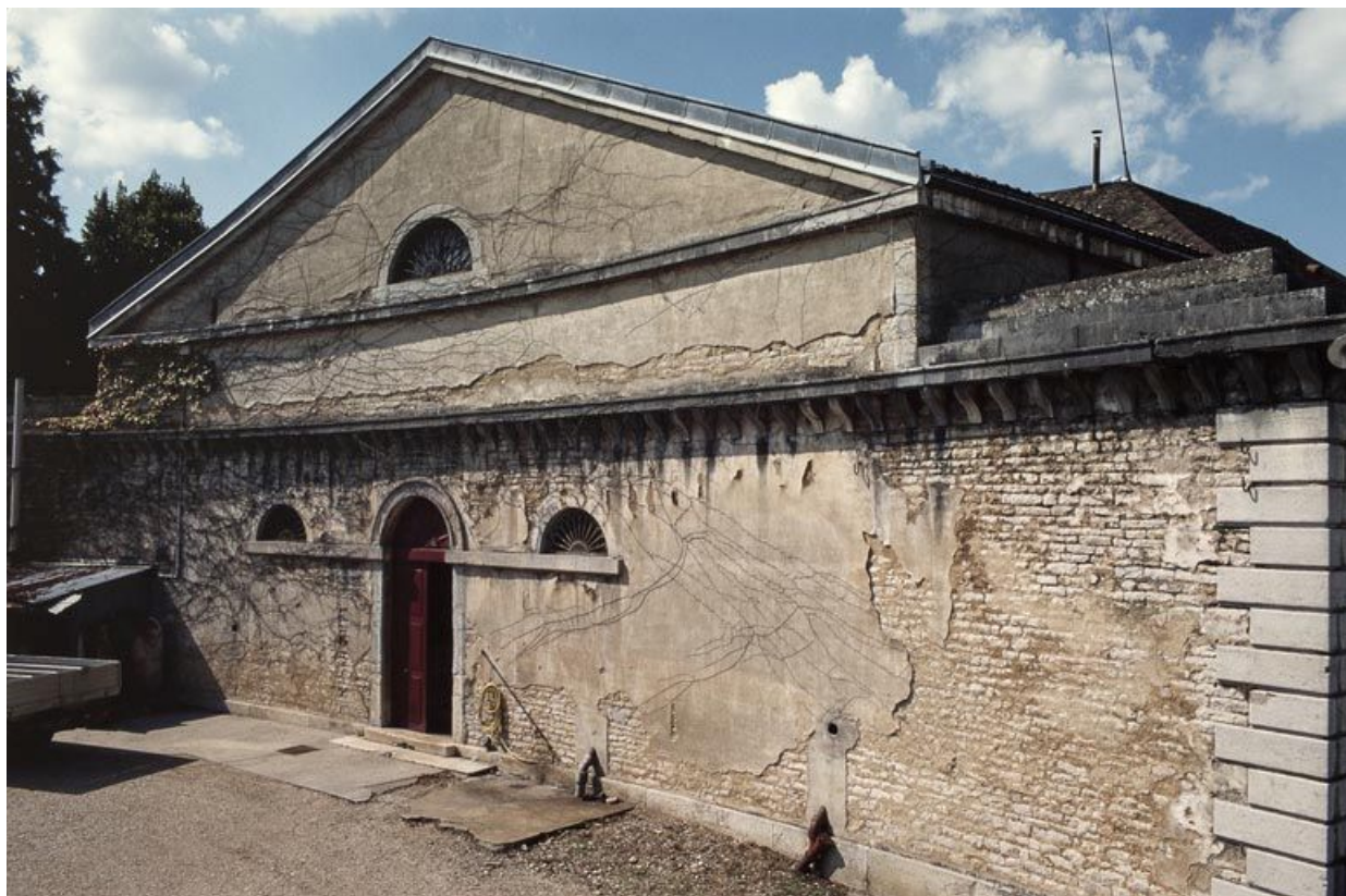
Grosse tour (improprement appelée bastion) des filles, ou de l'Oratoire, ou du Collège, ou Chanson. 21, Beaune boulevard Maréchal Foch
