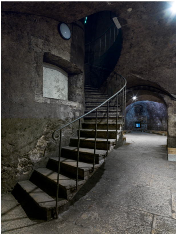
Caves, rez-de-chaussée : le monte-charge avec l'escalier tournant.
