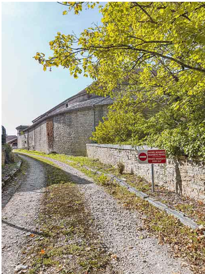
La rampe menant à la terrasse située au troisième étage de la tour. 21, Beaune boulevard Maréchal Foch
