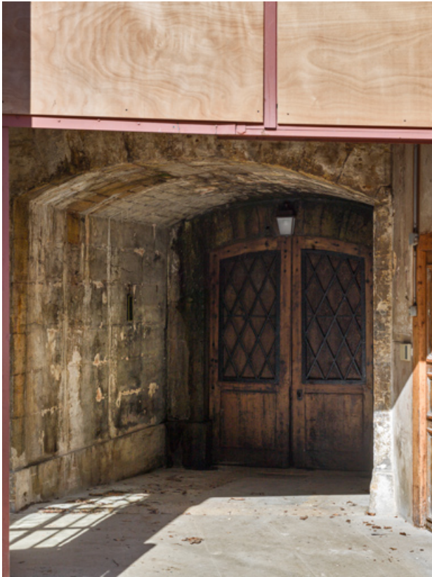
Entrée de la tour au rez-de-chaussée.
