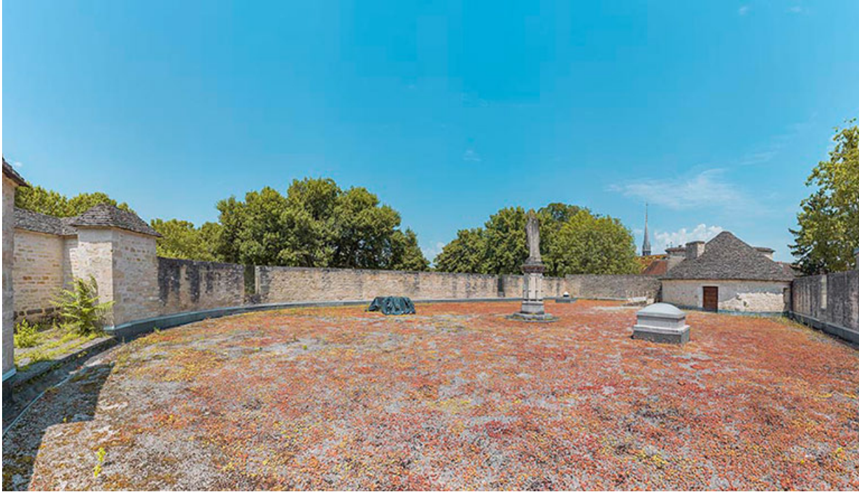
La plateforme supérieure de la tour : vue en direction de la gorge.
