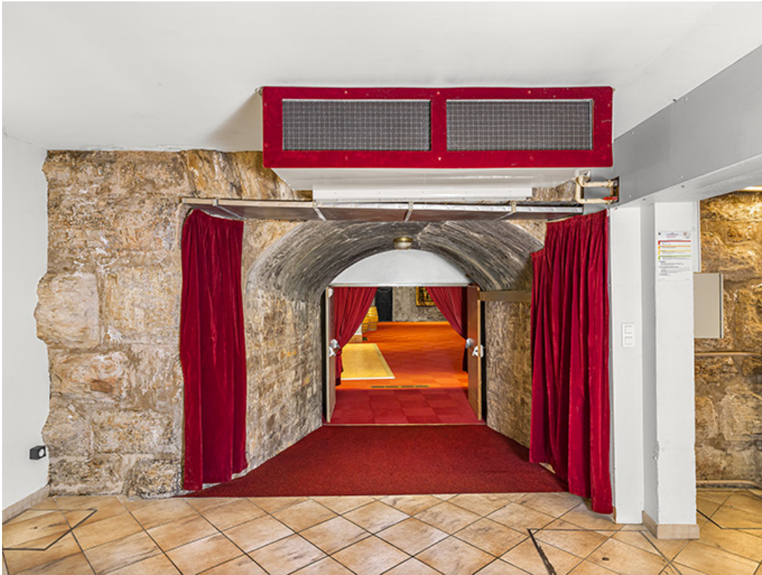
Passage voûté vers la cave de la tour (rez-de-chaussée). 21, Beaune boulevard Saint-Jacques
