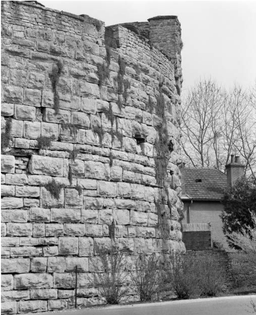
Grosse tour, improprement appelée bastion, de l'Hôtel-Dieu, depuis le fossé (1992). 21, Beaune boulevard Saint-Jacques
