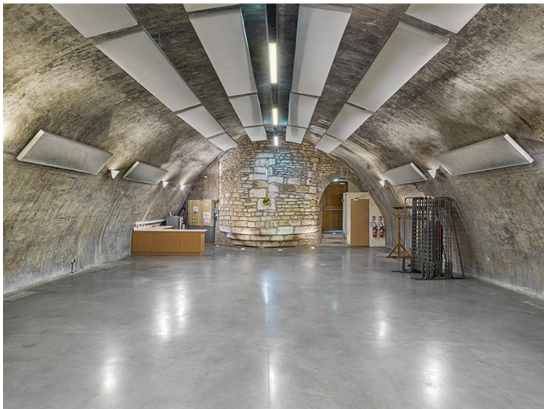
La cave et la tour des Billes englobée dans la Grosse Tour.
