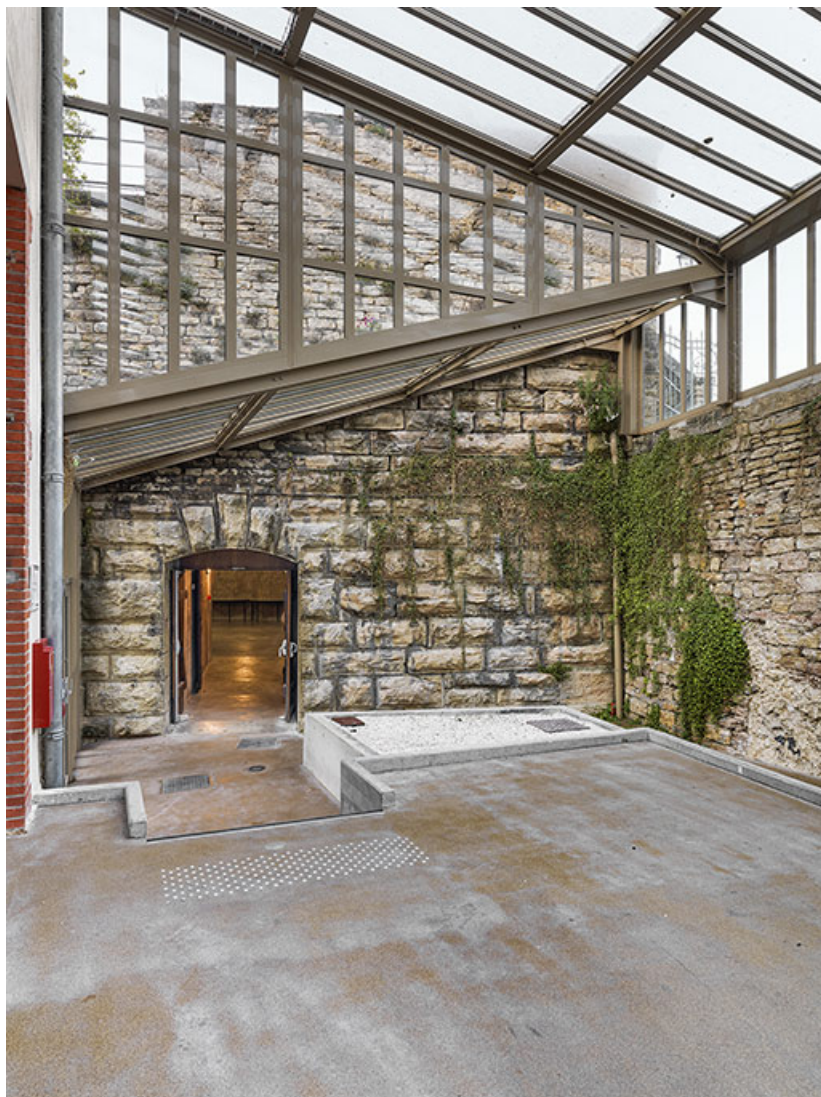
Détail de la maçonnerie et porte d'entrée.
