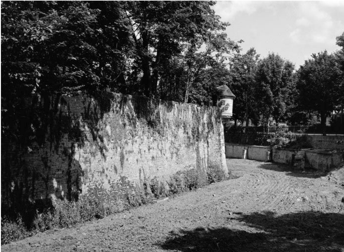
Bastion Notre-Dame, depuis le fossé : parapet est et échauguette 21, Beaune rempart de la Comédie
