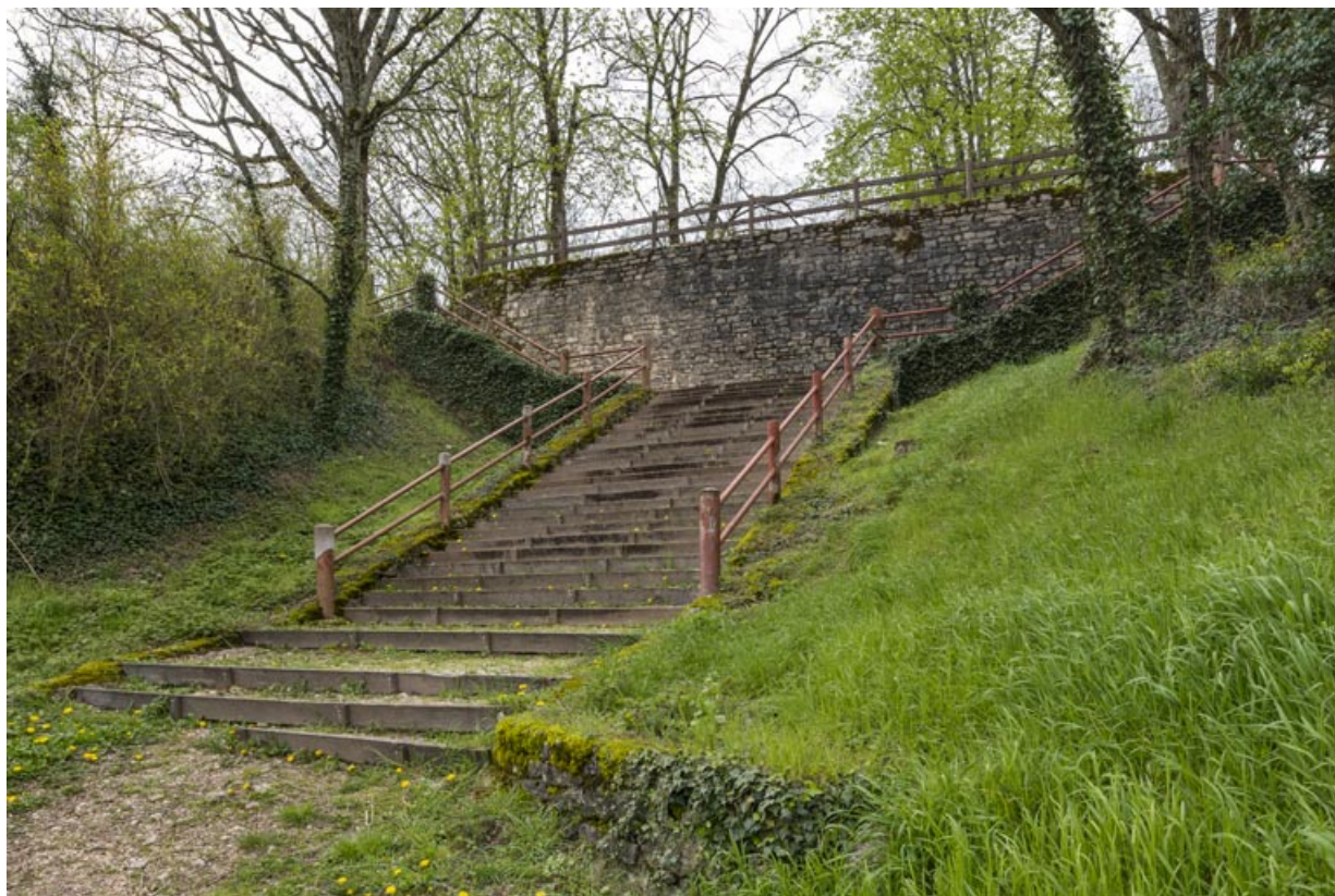
Escalier et mur de soutènement.
