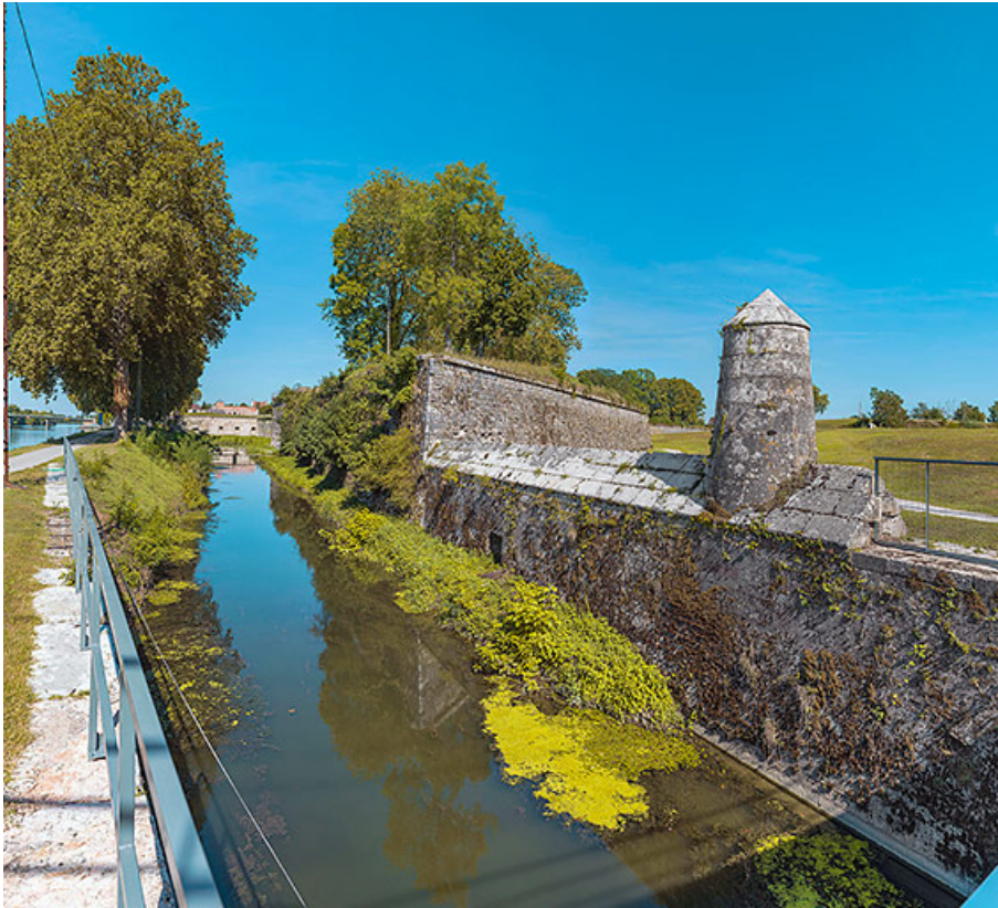
Le bastion et son batardeau.
