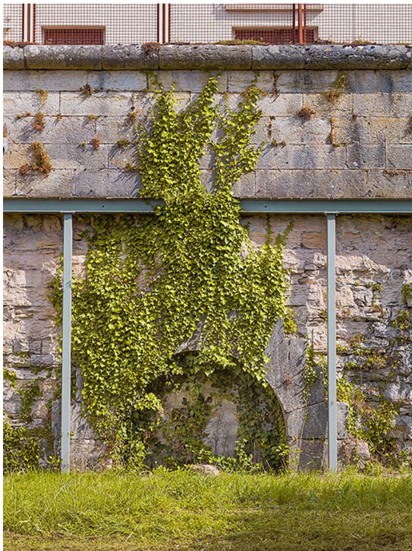
Le mur d'escarpe étayé (détail).
