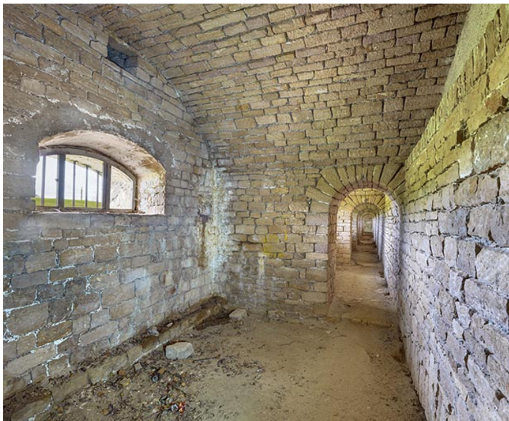
Galerie intérieure de la courtine.
