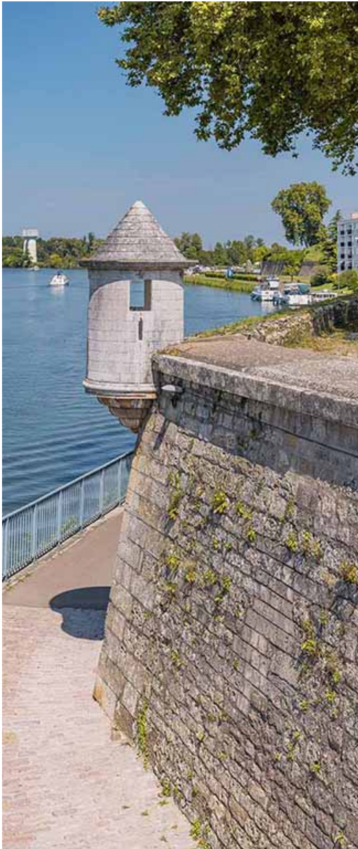
Le bastion prenant appui sur le chemin de halage. 21, Auxonne quai des Remparts
