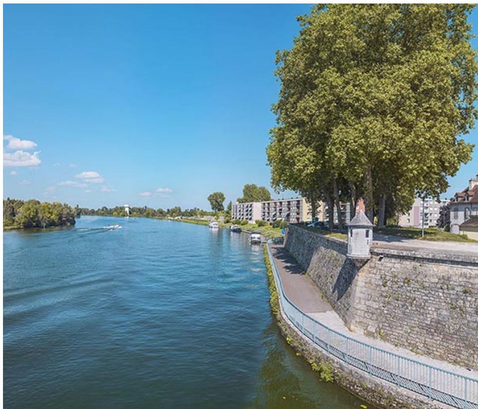
Vue du bastion en amont du pont.
