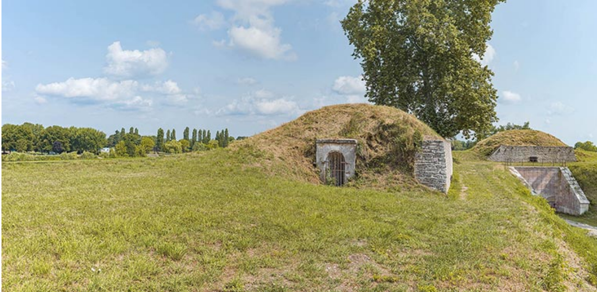
Entrée d'une des casemates sur le terre-plein.
