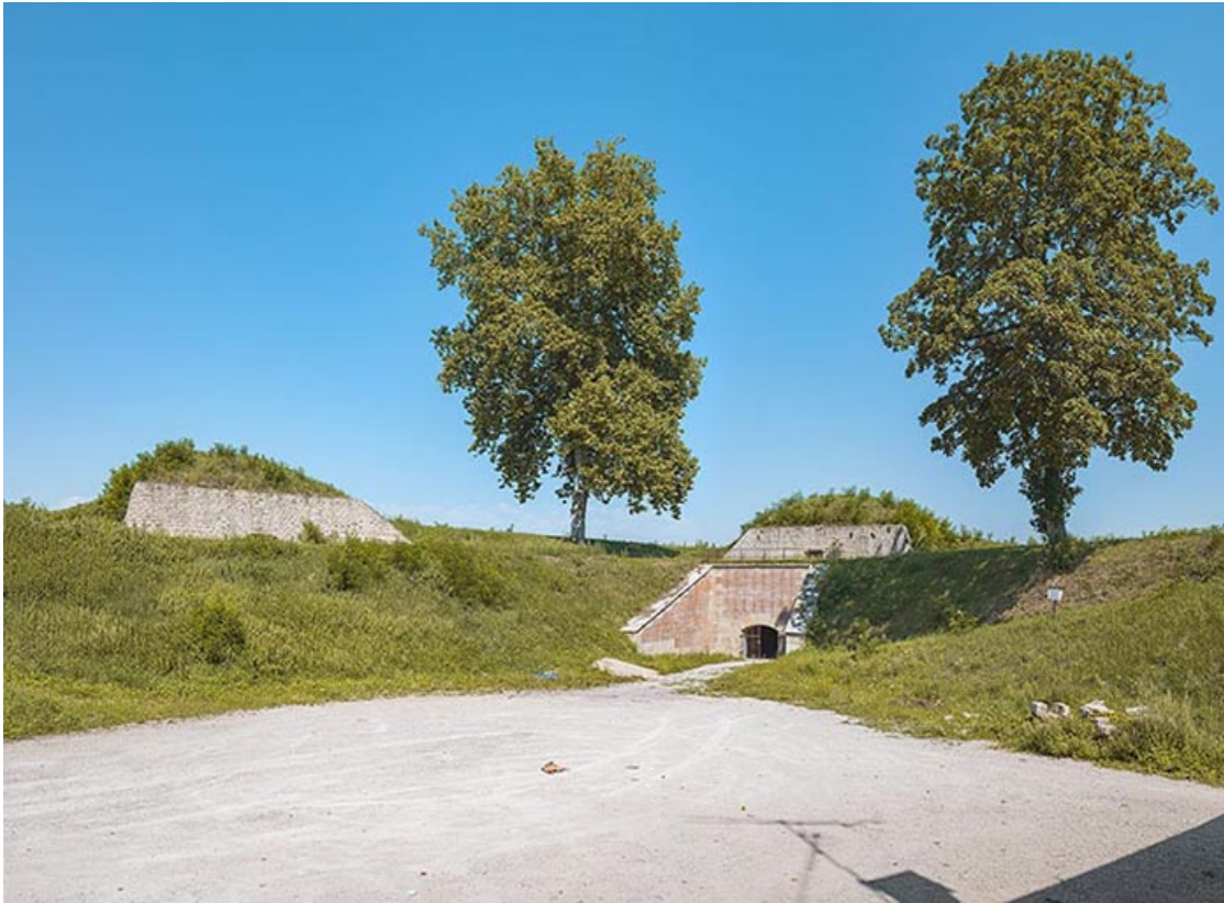
Vue générale du bastion depuis sa gorge.
