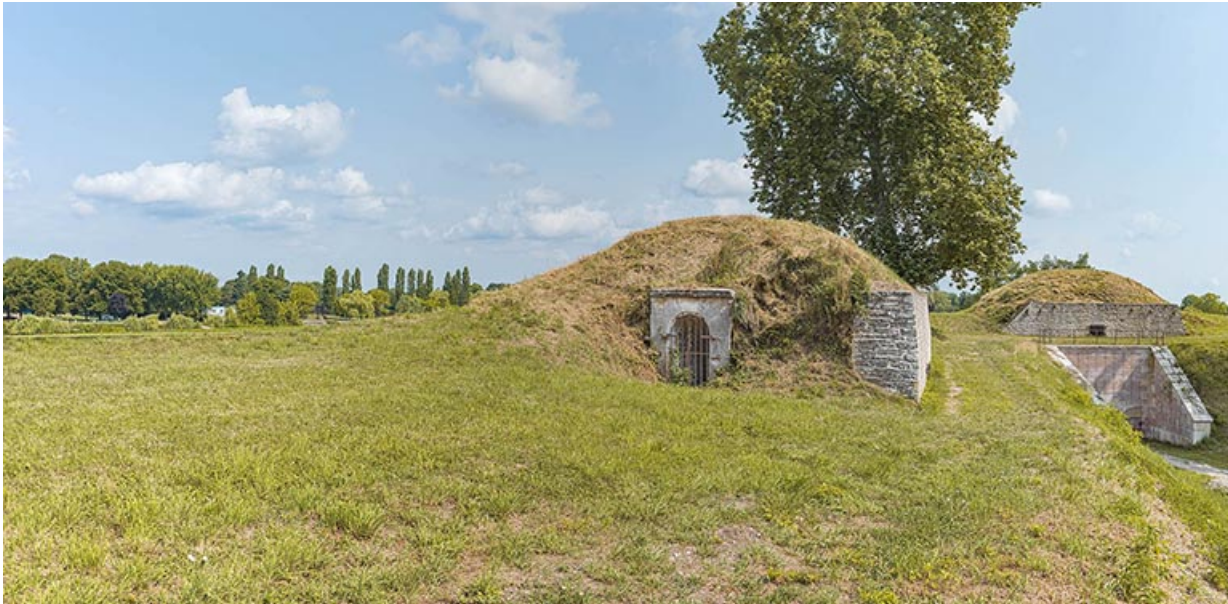
Entrée d'une des casemates sur le terre-plein.
