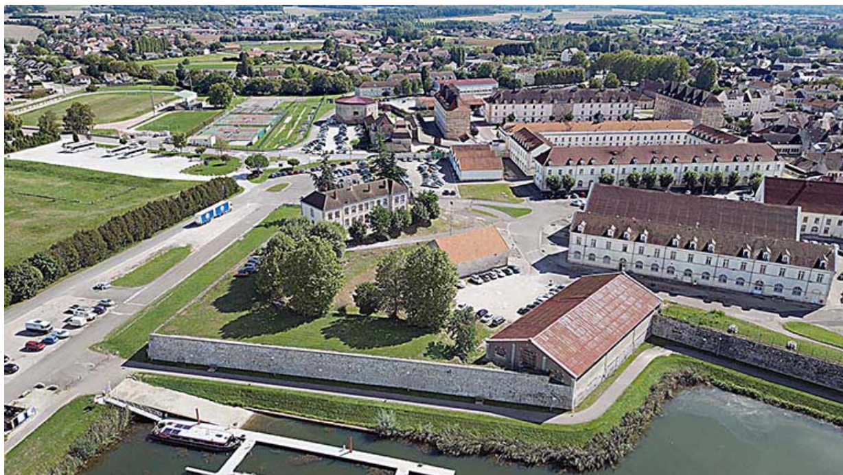
Vue aérienne : face et flanc ouest du bastion.
